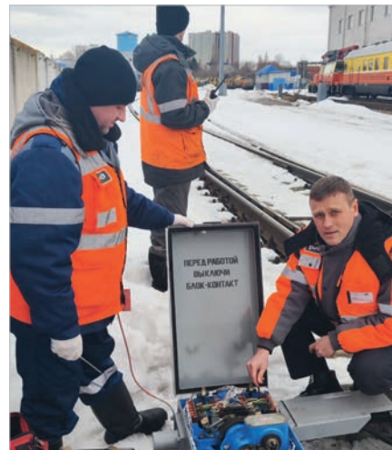
Контрольная проверка устройств СЦБ
