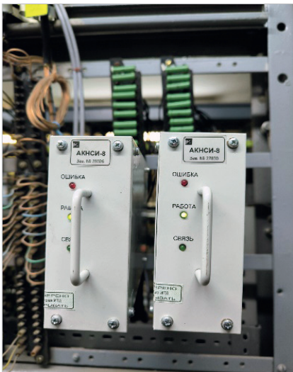
Восстановленное оборудование системы диагностики и мониторинга. Проект Тульской дистанции СЦБ
