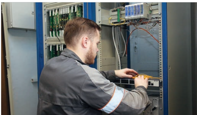
Старший электромеханик В.А. Лопатин выполняет монтаж оборудования
