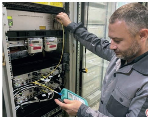
Электромеханик С.Ю. Колонков измеряет мощность оптического сигнала
