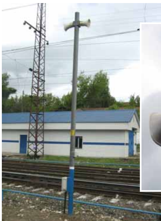
Внешний вид диэлектрической опоры и крепление громкоговорителя на опоре
