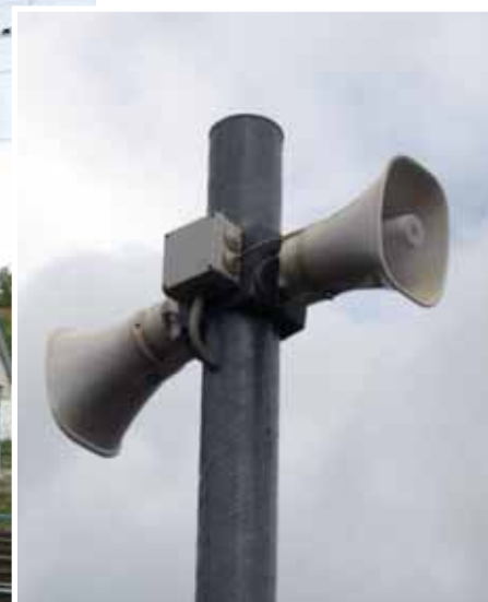
Внешний вид диэлектрической опоры и крепление громкоговорителя на опоре
