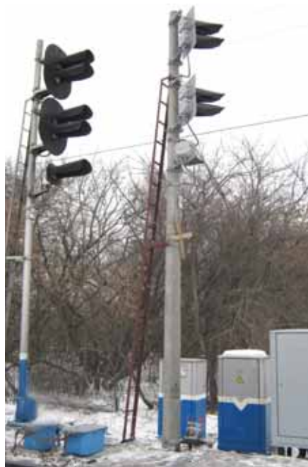
Полностью оборудованный новый светофор с заглушками на линзовых комплектах рядом с действующим
