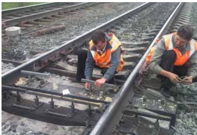
Электромеханики А.А. Чернышов и Ю.Б. Волков меняют устройства УКСПС на УКСПС-М
