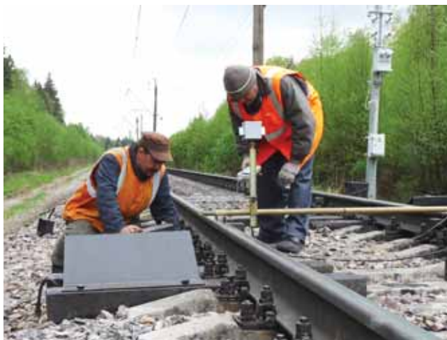
Электромеханики КТСМ С.В. Вагапов и Б.П. Карташов занимаются ориентацией напольных камер
