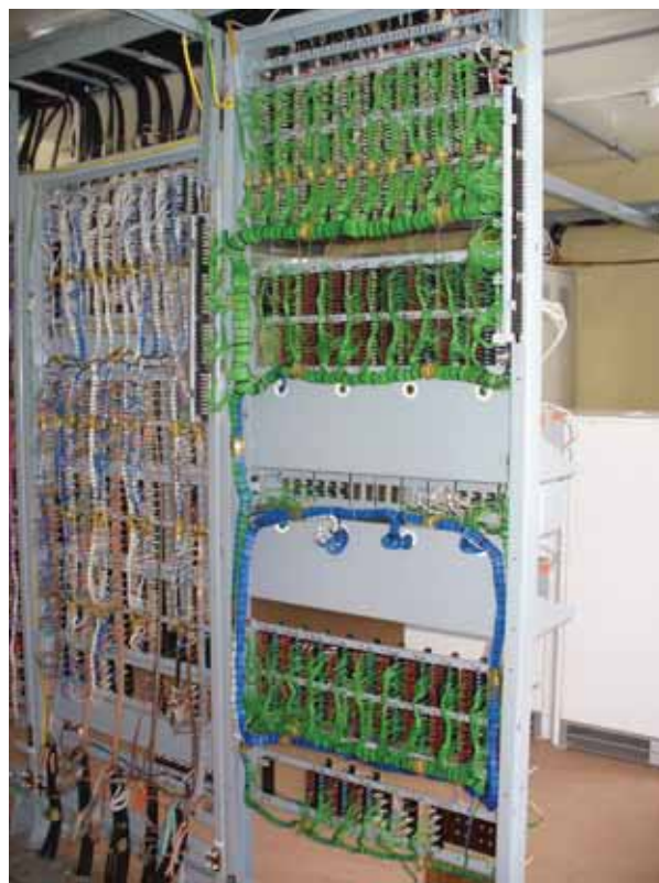
Диагностический статив с монтажной стороны
