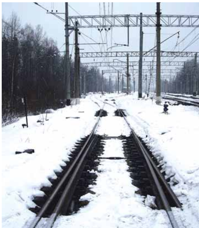
Обогреваемый стрелочный перевод
