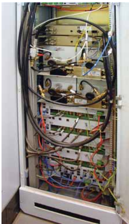
Базовая станция AS-300 технологической радиосвязи стандарта TETRA
