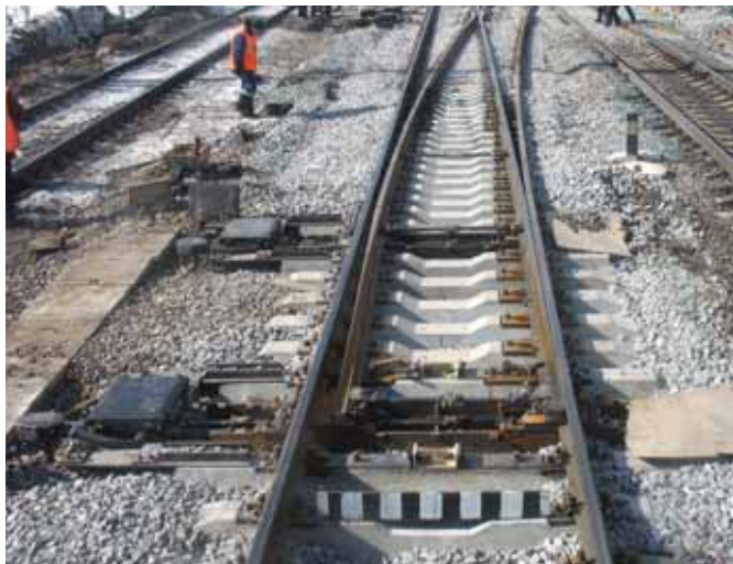
Стрелочный перевод 2956 с внешними замыкателями ВЗ-7
