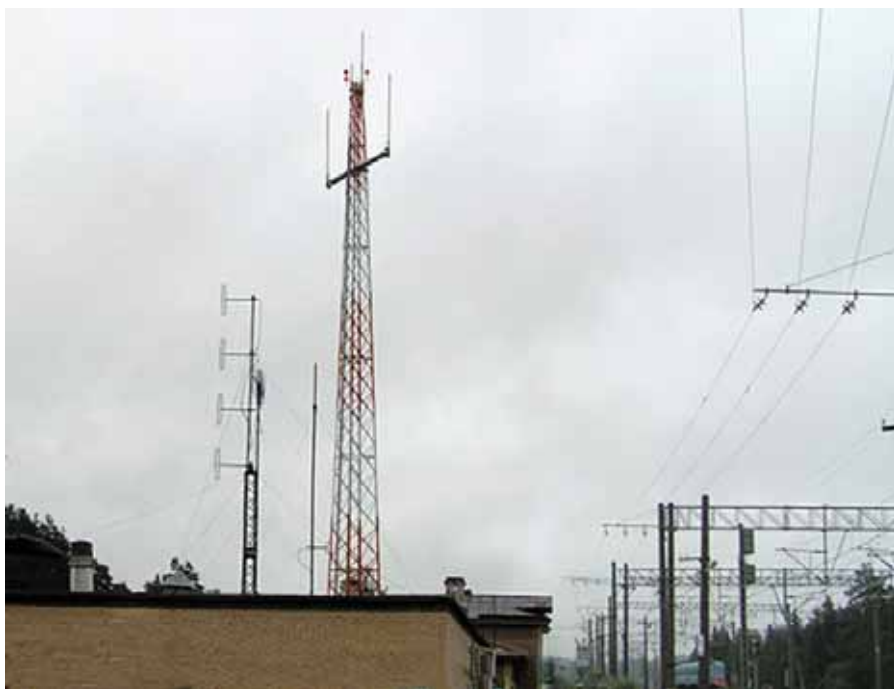
Антенно-фидерное сооружение технологической радиосвязи стандарта TETRA
