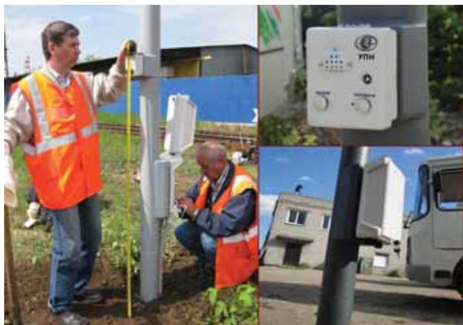
Установка оборудования ПСГО с использованием электрических изделий и коммутационной диэлектрической стойки
