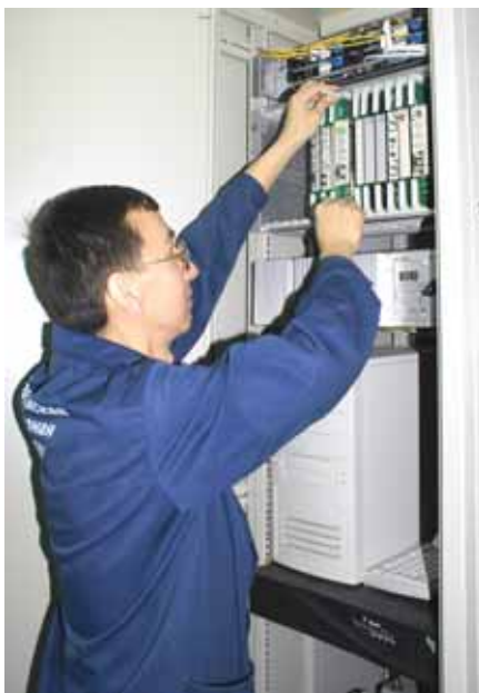
Инженер С.Е. Бабаджанов производит замену платы в оборудовании MBTK-2
