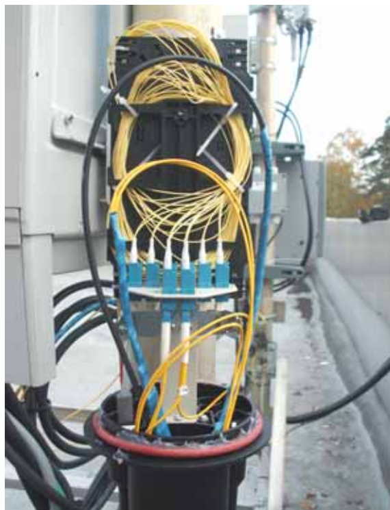
Внутреннее устройство муфты-бокса МТОК-Л6Б-16LC
