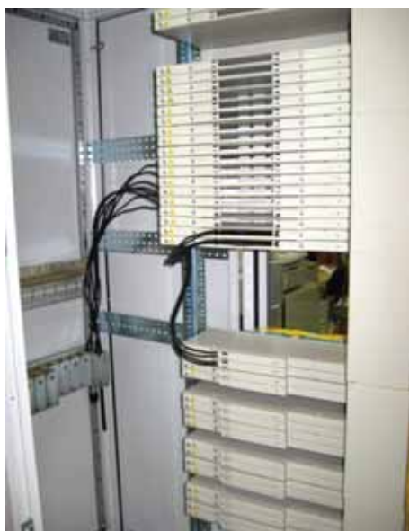
Секции главного кросса ВОЛП, смонтированные в напольном шкафу
