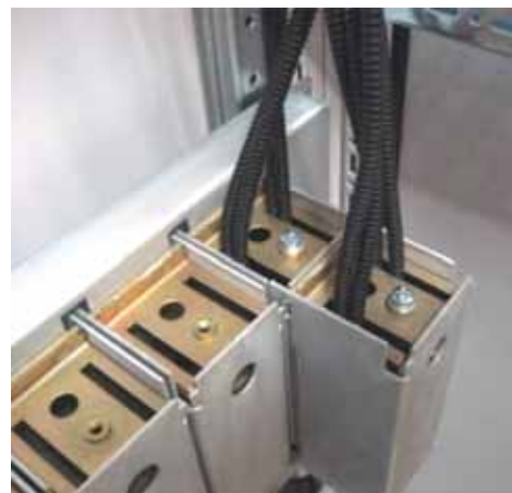
Блок кабельных вводов ВКР с уходящими к шкафам транспортными трубками
