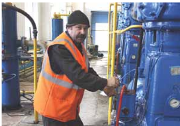
Электромеханик компрессорной Александр Остер регулирует лубрикатор насоса высокого давления
