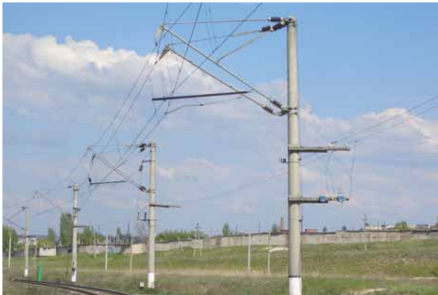
Двухпроводный волновод на электрифицированном участке Волгоград – Разгуляевка
