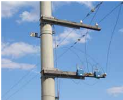
Секционирование двухпроводного волновода
