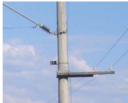
Варианты исполнения двухпроводного волновода на траверсах ТМК 001.02
