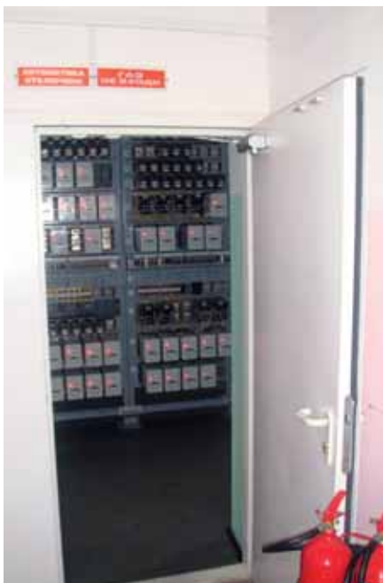
Помещения с аппаратурой СЦБ и связи оборудуются дверями в противопожарном исполнении
