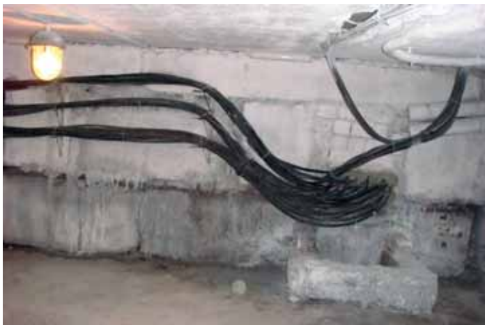
Герметизация стен, пола и кабельных вводов специализированными материалами полностью исключила попадание воды в подвальные помещения
