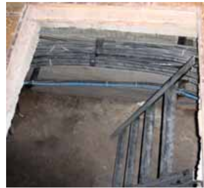
Приведение в порядок кабельных ниш существенно повышает пожаробезопасность постов ЭЦ
