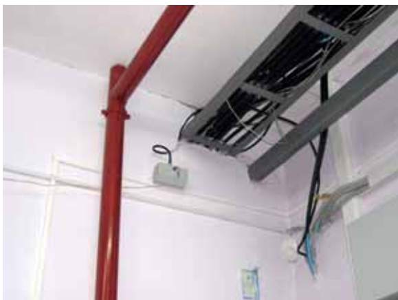
Места прохода кабелей СЦБ герметично заделываются специальным раствором
