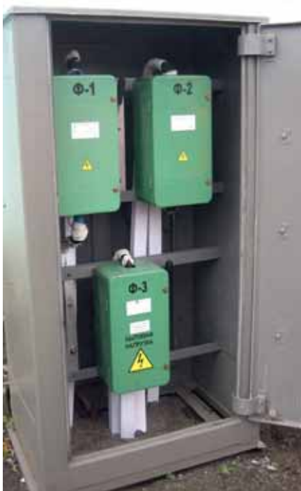
Пример разделения питания постов ЭЦ и организации места отключения напряжения в аварийных ситуациях
