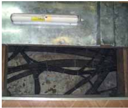
Приведение в порядок кабельных ниш существенно повышает пожаробезопасность постов ЭЦ
