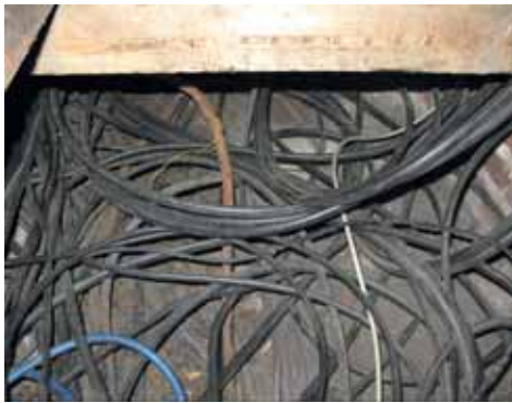
Подобным образом кабельное хозяйство содержать недопустимо
