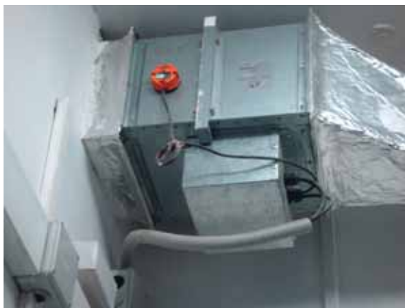
При срабатывании пожарной сигнализации клапаны своевременно перекроют вентиляционную систему и обеспечат необходимую герметичность
