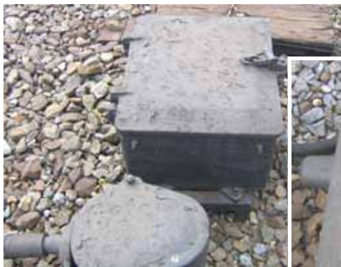
Примерно так выглядят путевые ящики, электроприводы и муфты спустя год после покраски традиционным способом
