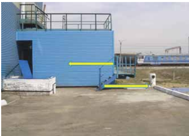
Организация раздельного ввода кабелей связи на станции Мегет
