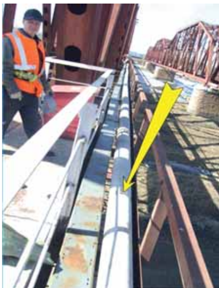
Защита кабеля на мосту через реку Уда
