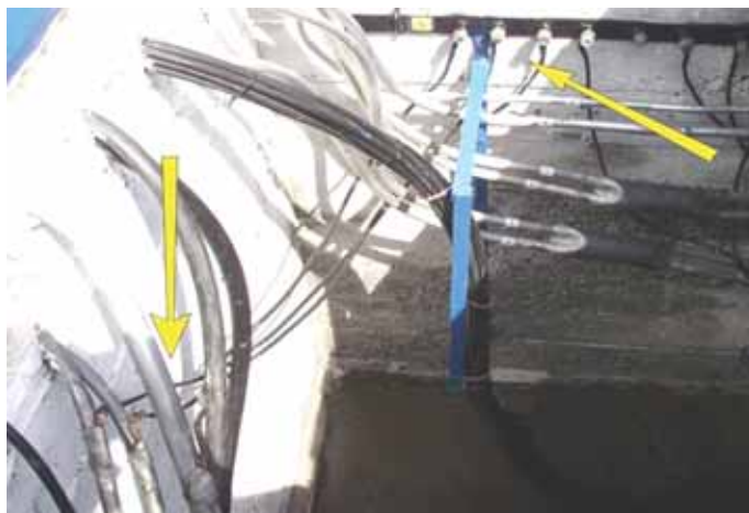
Пример заземления кабелей связи в оболочке на общий контур заземления поста ЭЦ
