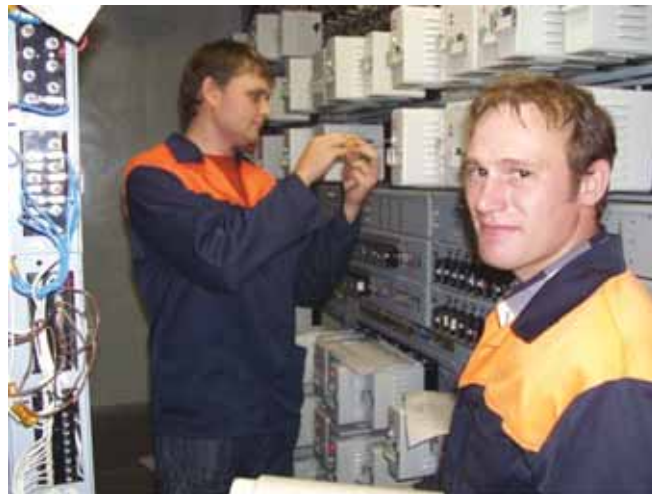
Старший электромеханик А.В. Шарко и электромеханик А.Н. Дерин во время регулировки аппаратуры ТРЦ на посту ЭЦ Северного парка станции Аллагуват
