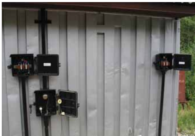
Элементы защиты от перенапряжений в кабельных ящиках
