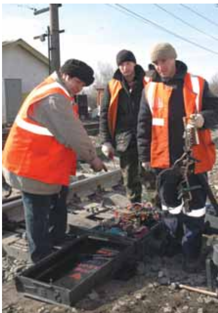
Электромеханики Л.Л. Траутмане, А.А. Савочкин и В.В. Прахт меняют монтаж в электроприводе
