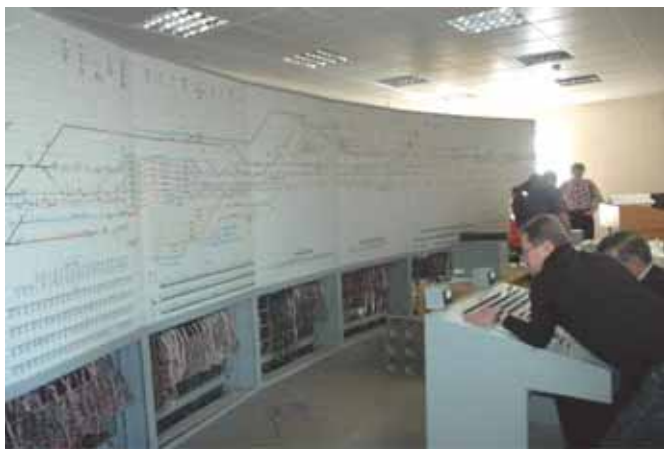
В аппаратной поста ЭЦ Владимир кипит работа – перед вводом устройств в эксплуатацию нужно проверить все зависимости
