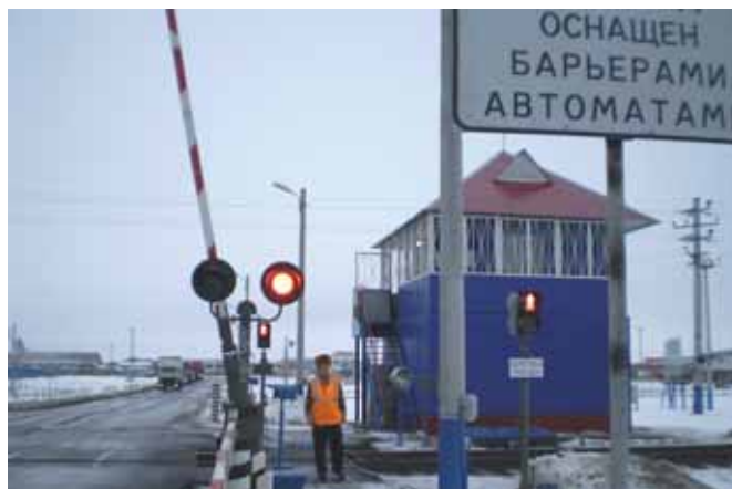
Переезд, оборудованный устройствами заграждения
