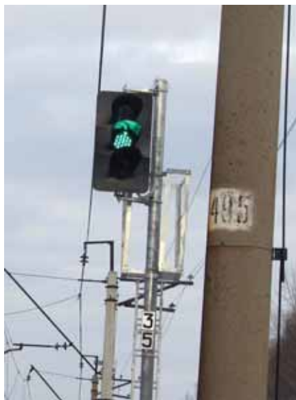
Светофор, оборудованный СЖДМ новой конструкции
