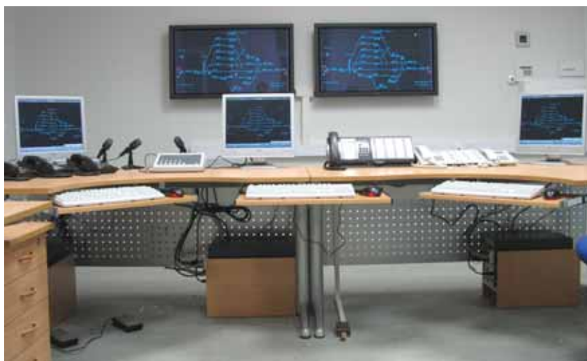
Рабочее место дежурного по станции с двумя зонами управления
