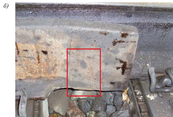
Рис. 12. Трещины литой части цельнолитого блока моноблочной крестовины в районе улавливающего желоба: a — вид слева; б — вид справа
