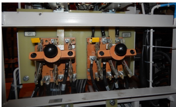
Рисунок 23 – Рабочее положение ножей QR1 и QR2
