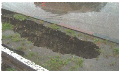
Рисунок 11. Промоина в балласте
