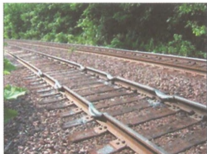
Рисунок 8. «Пропил» рельса
