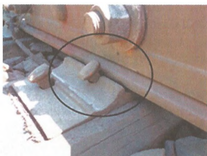
Рисунок 4. «Провисание» рельса
