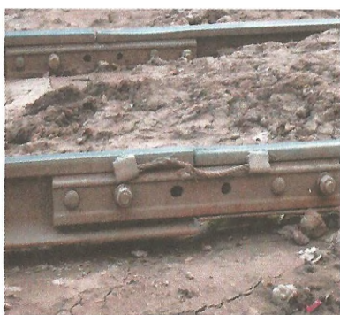
Рисунок 12. Нарушение крепления (повреждение) шунта межстыкового соединения
