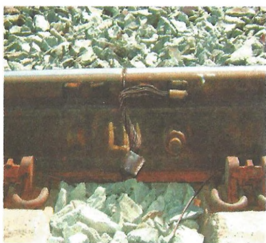
Рисунок 12. Нарушение крепления (повреждение) шунта межстыкового соединения
