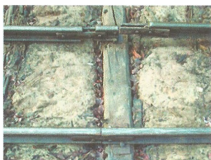
Рисунок 6. Разрыв стыка соединения рельсов
