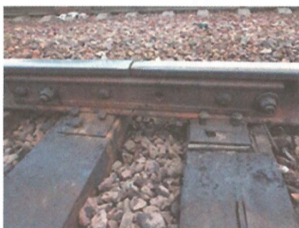
Рисунок 5. Отсутствие болта в крепеже накладки стыка рельсов
