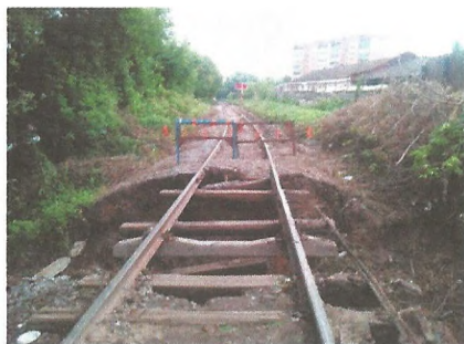
Рисунок 10. Подмыв земляного полотна
