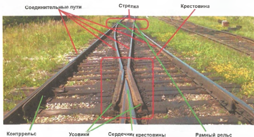
Рисунок 1. Устройство стрелочного перевода
