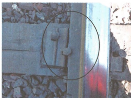
Рисунок 3. Выход подошвы рельса из-под реборд
