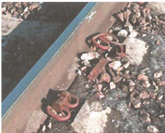
Рисунок 7. Нарушение крепления рельса к шпале (крепления упорной клеммы)
