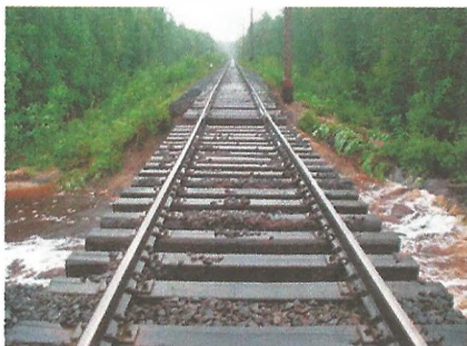
Рисунок 10. Подмыв земляного полотна
