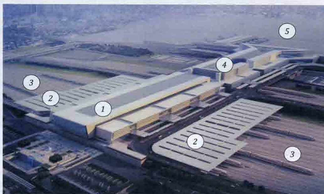
Рис. 19.18. Шанхайский хаб Хунцяо: 1 — здание вокзала железнодорожной станции; 2 — крытые пассажирские платформы; 3 — приемо-отправочные пути высокоскоростных поездов; 4 — терминал аэропорта; 5 — летное поле аэропорта
