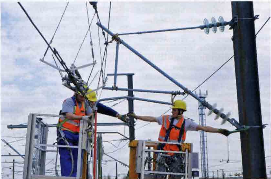
Рис. 20.30. Регулировка положения контактного провода на ВСМ. Франция
