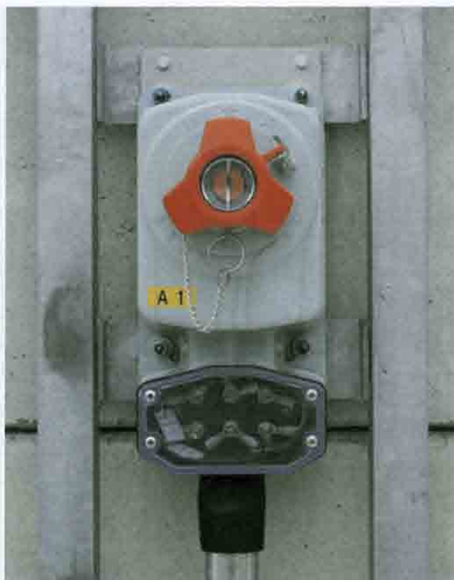
Рис. 17.11. Сигнальная кнопка экстренной остановки поезда, размещенная на подпорной стенке ВСМ «Кюсю». Япония. 2010 г. Для подачи сигнала экстренной остановки поезда необходимо выдернуть чеку, отвернуть защитную крышку красного цвета, сорвав при этом пломбу, а затем — нажать кнопку
