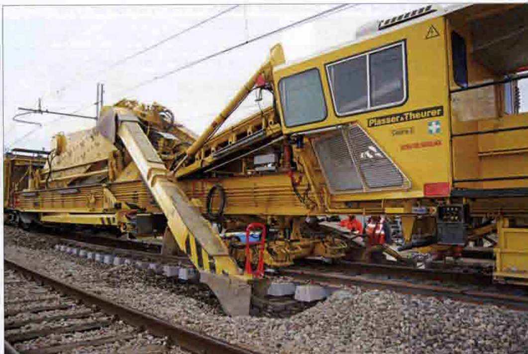
Рис. 20.20 (окончание): б — действующий рабочий орган (хорошо видна цепь, проходящая под рельсошпальной решеткой, выгребающая загрязненный балласт)
