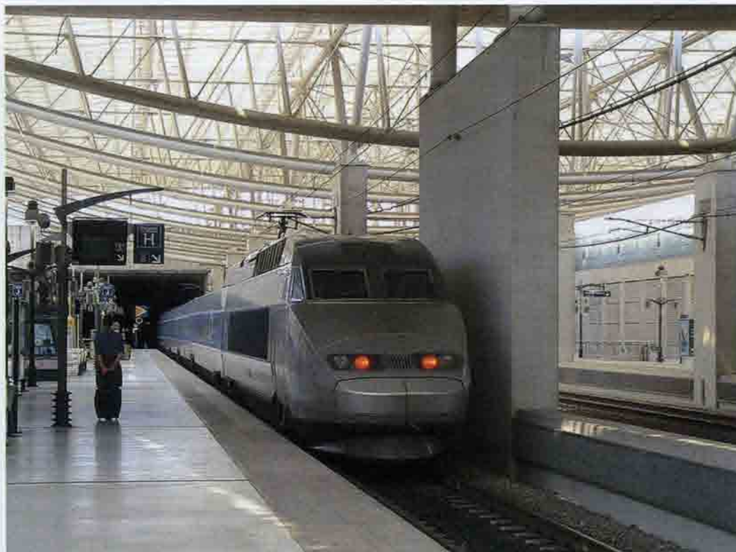
Рис. 19.16. Пассажирская платформа высокоскоростных поездов на железнодорожной станции Аэропорт Шарль де Голль
