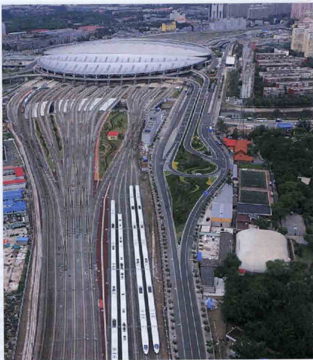
Рис. 19.12. Общий вид станции Пекин-Южный. На заднем плане — здание вокзала; внизу справа — вагонные тракционные пути для отстоя высокоскоростных поездов
