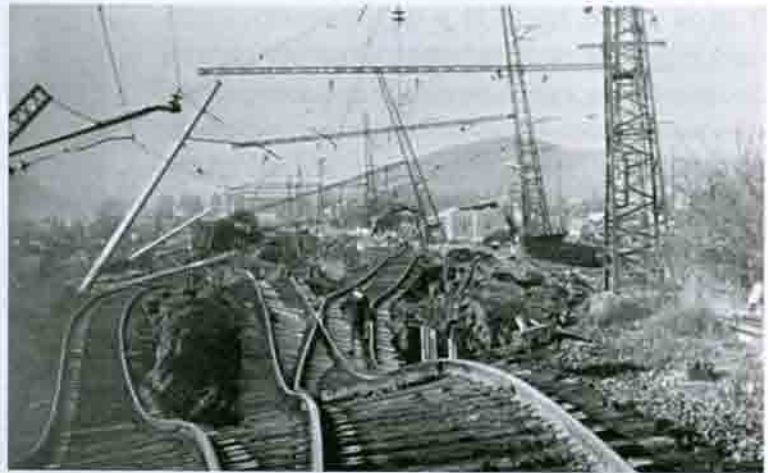
Рис. 17.20. Разрушение верхнего строения пути в районе станции Налбанд в Армении Спитакским землетрясением 7 декабря 1988 г.
