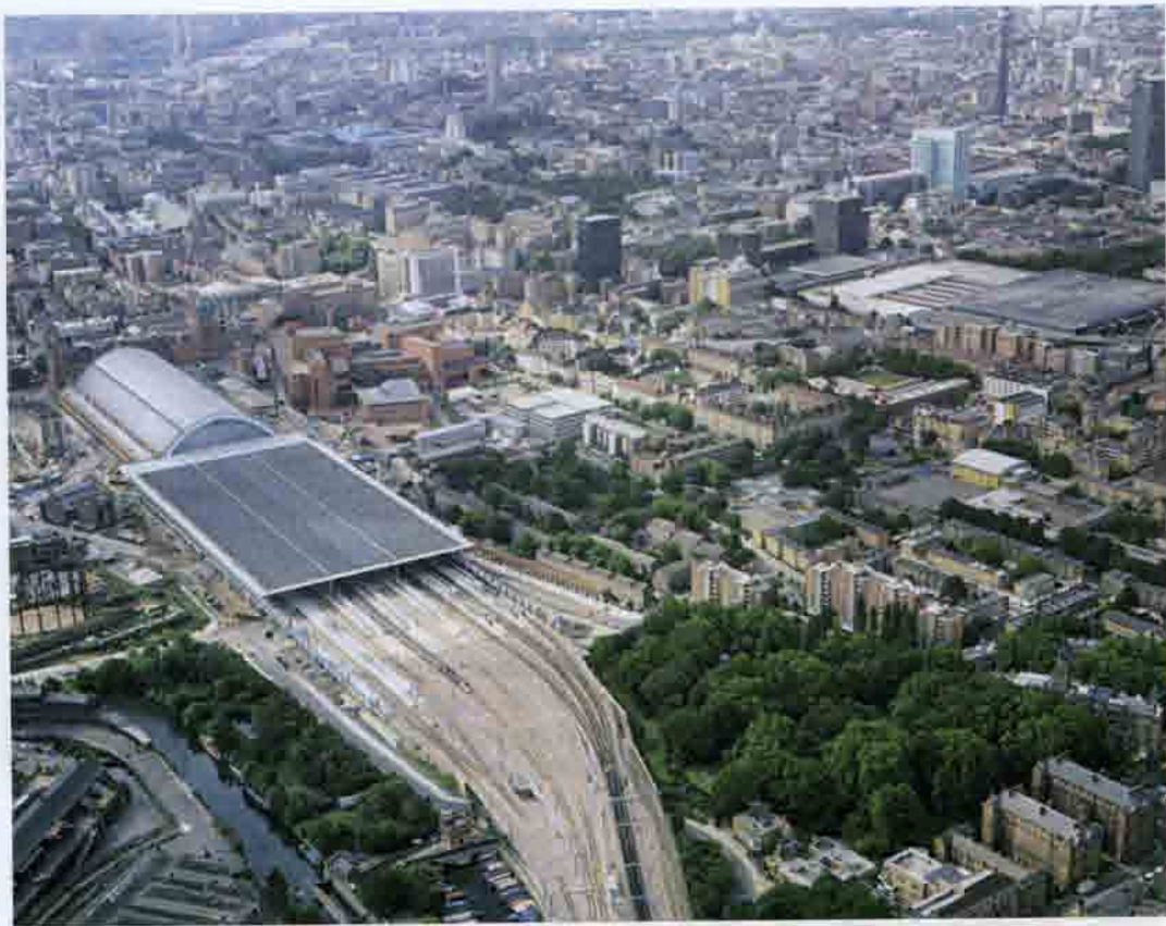
Рис. 19.10. Вокзал Сейнт-Панкрас в Лондоне после реконструкции. В центре — новая плоская крыша над пассажирскими платформами. 2011 г.
