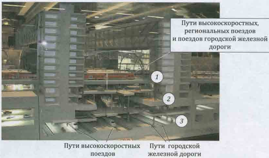
Рис. 19.8. На фотографии макета Главного вокзала Берлина в разрезе показаны: 1 — верхний уровень; 2 — средний уровень; 3 — нижний уровень
