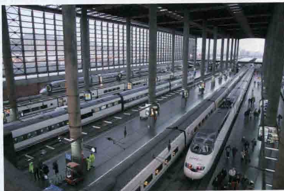
Рис. 19.4. Вокзал Аточа в Мадриде. Испания. 2012 г.: а — зал ожидания (до реконструкции — зал прибытия и отправления поездов) с тревеллейтерами, доставляющими пассажиров на разные уровни вокзала; б — крытые перронные пути для высокоскоростных поездов
