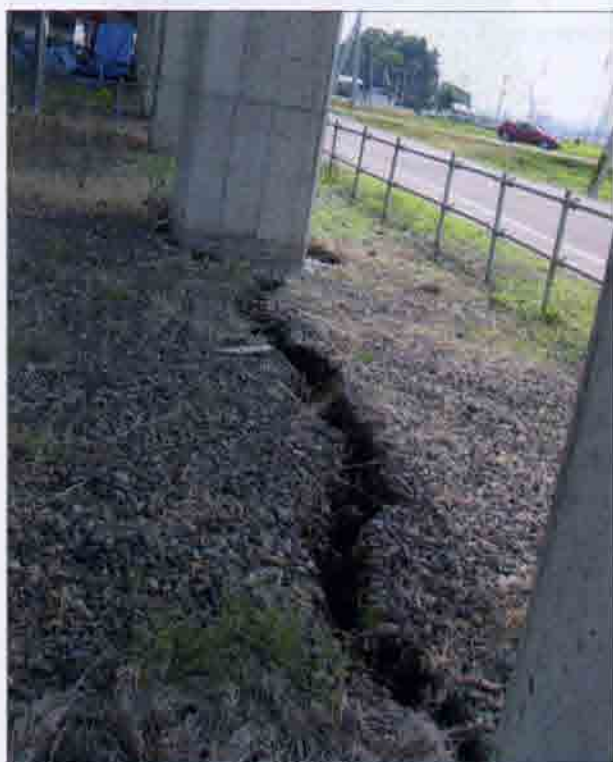
Рис. 17.23. Последствия землетрясения 31 октября 2004 г.: а — сорванное рельсовое крепление; б — искривленные и разрушившиеся в момент сейсмического толчка рельсы, уложенные на плитном основании на эстакаде; в — трещины в грунте у опоры эстакады
