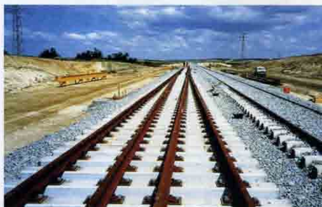
Рис. 6.56. Основные этапы укладки стрелочного перевода на ВСМ: а — раскладка переводных брусьев; б — монтаж элементов перевода с помощью крана; в — стрелочный перевод, подготовленный к монтажу переводного механизма и электроприводов; г — устройства электрообогрева стрелки
