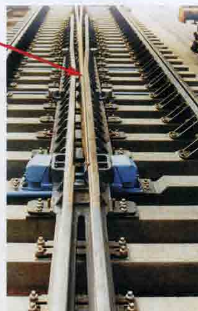
Рис. 6.50. Крестовины стрелочных переводов: а — литая (стрелками показано «мертвое пространство»: здесь колесо, переходя с одной рельсовой нити на другую, на некотором отрезке пути теряет опору); б — крестовина с подвижным сердечником, обеспечивающая непрерывную поверхность катания колеса
