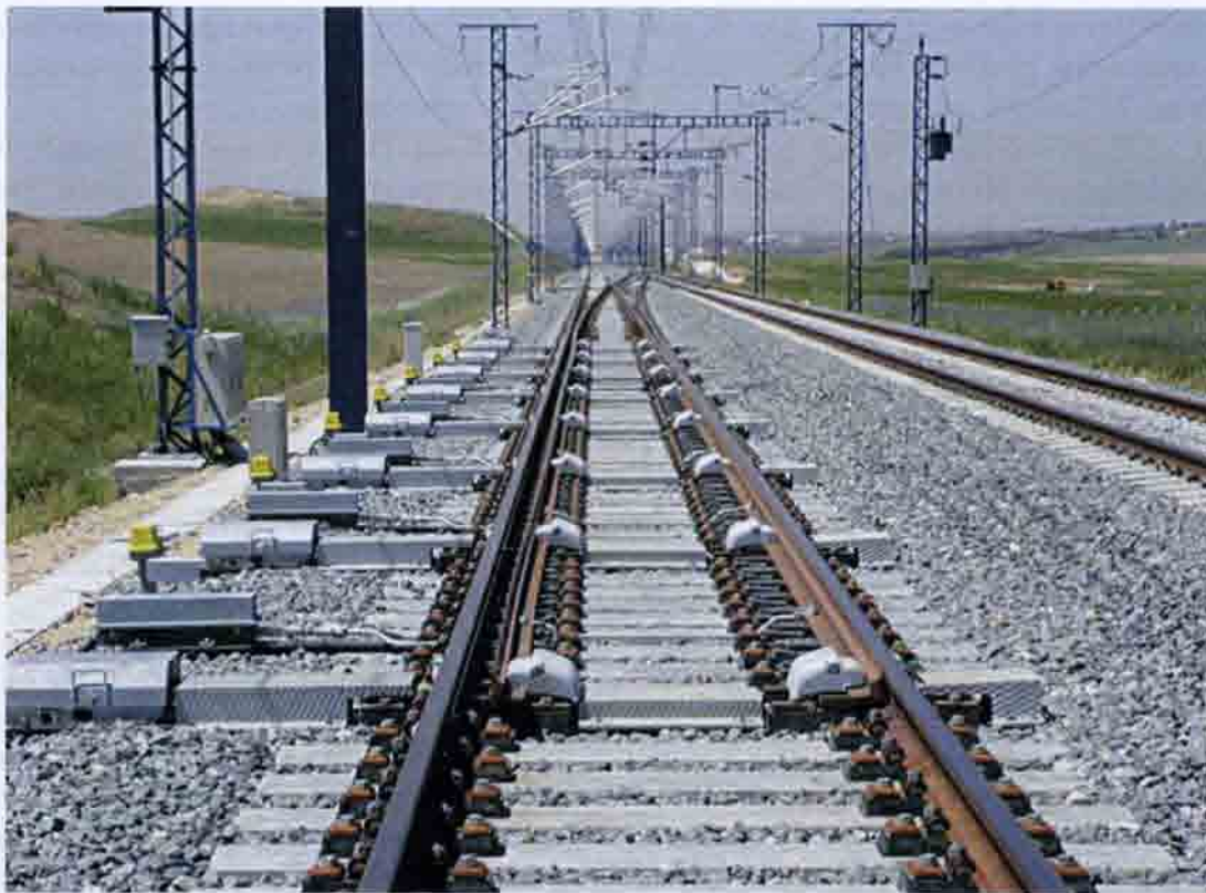
Рис. 6.57. Готовый к эксплуатации стрелочный перевод на ВСМ. Испания. 2009 г.
