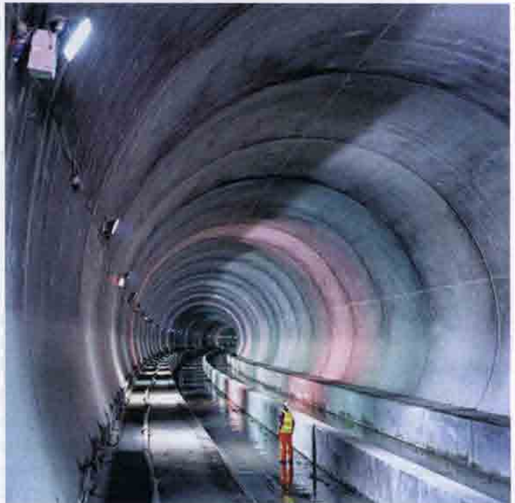
Рис. 8.24. Тоннель под Ла-Маншем на ВСМ Лондон — Париж в процессе завершения строительства: а — механизированный проходческий комплекс; б — пройденный участок тоннеля. На рис. (б) виден желоб в центре тоннеля, куда будет уложен путь, и широкая бетонная полка вдоль левой стены, предназначенная для высадки пассажиров из поездов в аварийных ситуациях, используемая также как путь эвакуации людей при проведении аварийно-спасательных работ
