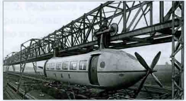
Рис. 2.2. Монорельсовая транспортная система Г. Бенни «Railplane» (от англ. «Рельсовый самолет»). Великобритания. 1929 г.
