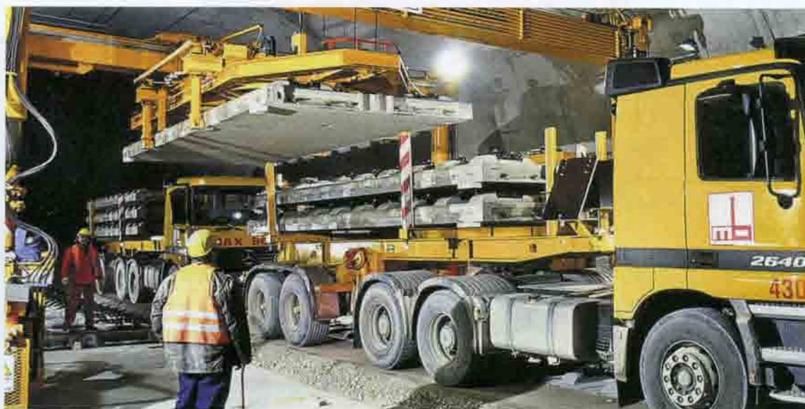
Рис. 6.38 (окончание). Плиты типа «Vögl»: в — транспортировка плит к месту монтажа
