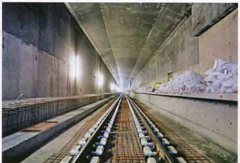
Рис. 8.30. Строительство тоннеля «Мармарай» под Босфором: а — железобетонная секция тоннеля в процессе транспортировки к месту установки; б — внутренний вид строящегося тоннеля
