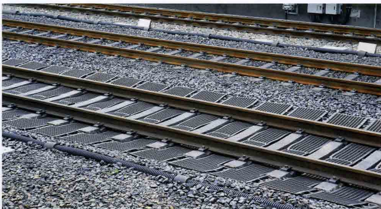
Рис. 6.9. Путь на шпалах и балласте, прикрытый резиновыми сетчатыми матами. ВСМ. Япония
