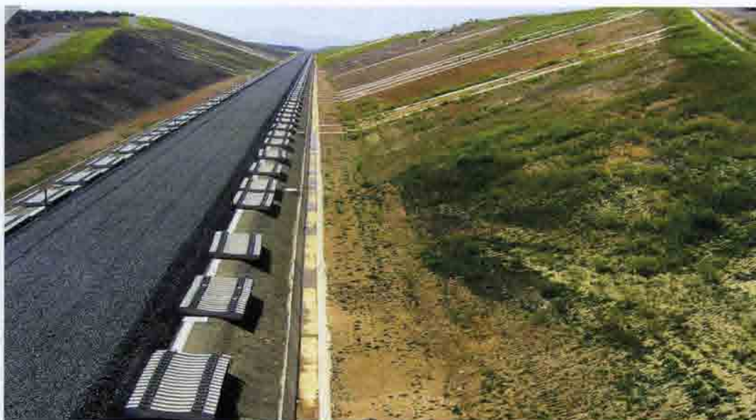
Рис. 6.12. Участок будущей ВСМ с уложенным балластным слоем, подготовленный для раскладки шпал. Испания. 2000 г.
