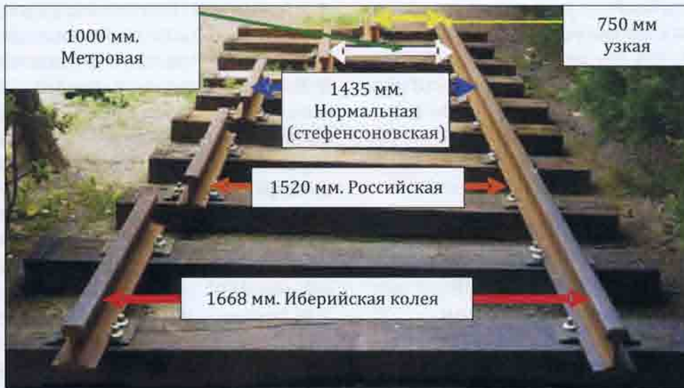
Рис. 7.1. Самые распространенные в настоящее время стандарты ширины колеи
