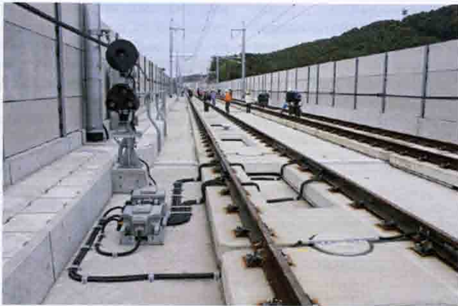
Рис. 6.29. Путь на плитах-рамах на ВСМ Кюсю. Япония. 2010 г.
