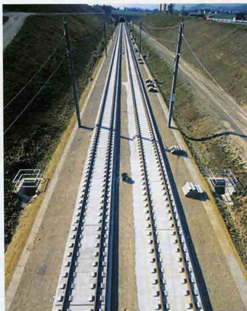
Рис. 6.46. Общий вид безбалластной конструкции пути типа «ÖBB Porr». Австрия. 2010 г.
