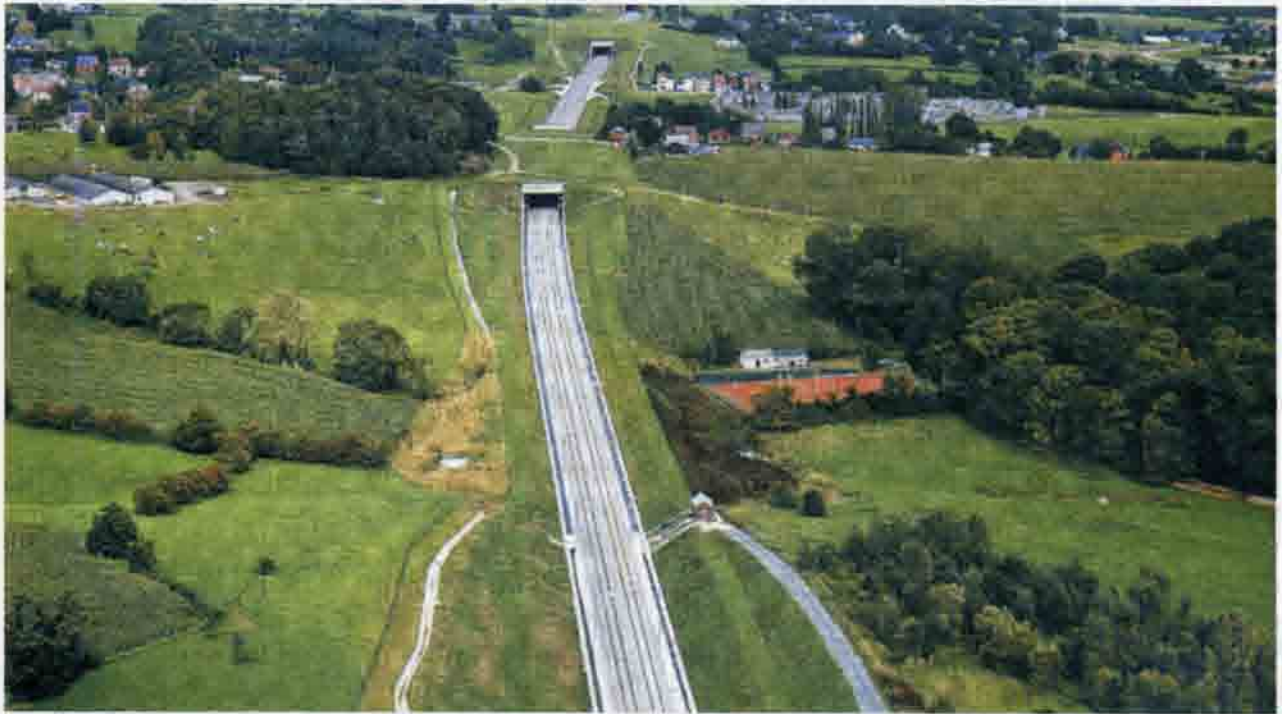
Рис. 3.7. Пример рекультивации территории после строительства ВСМ с устройством пути в выемке для защиты от шума и сооружением, так называемых, «ландшафтных» путепроводов, скрывающих железнодорожные пути. Великобритания. 2000 г.
