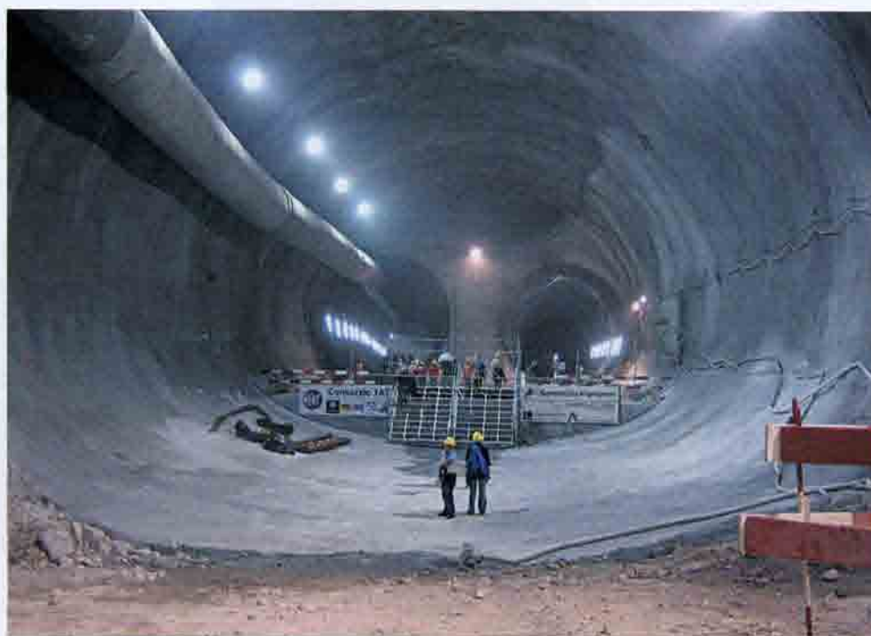
Рис. 8.27. Готтардский базисный тоннель: строительство подземной многофункциональной станции Файдо. Соединительный тоннель между главным западным и главным восточным туннелями для устройства съезда между главными путями. 2006 г.
