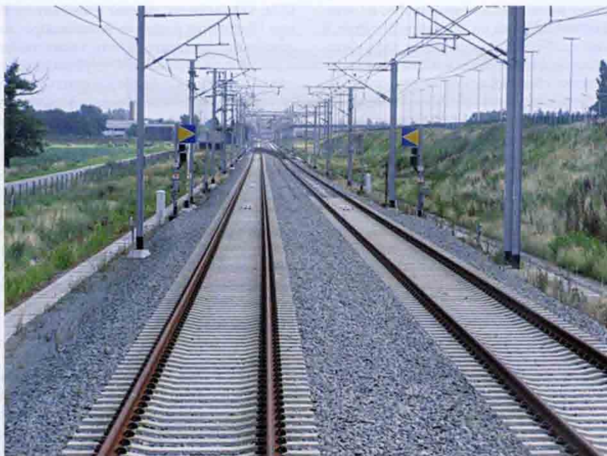
Рис. 6.23. Готовый к эксплуатации участок пути ВСМ на балласте и шпалах. Франция
