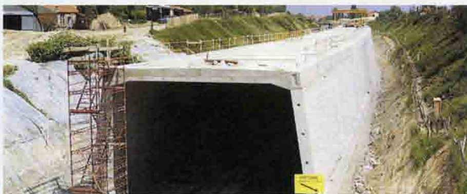
Рис. 8.32. Сооружение тоннеля открытым способом: а — общий вид; б — вид со стороны портала
