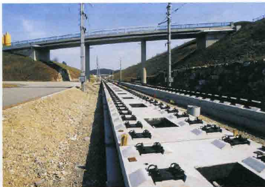
Рис. 6.45. Плиты пути системы «ÖBB Porr» в процессе монтажа, подготовленные к укладке рельсов. 2010 г.
