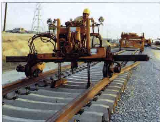
Рис. 6.19. Варианты применения различных машин при укладке (надвижке) рельсовых плетей на шпалы
