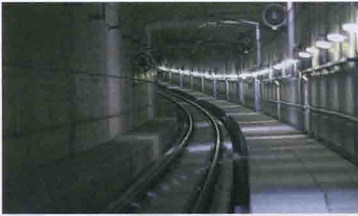
Рис. 8.39. Тоннель мелкого заложения с эвакуационной платформой для высадки пассажиров (слева) и аварийно-эксплуатационной дорогой (справа) ВСМ «Юг», Нидерланды. 2008 г.
