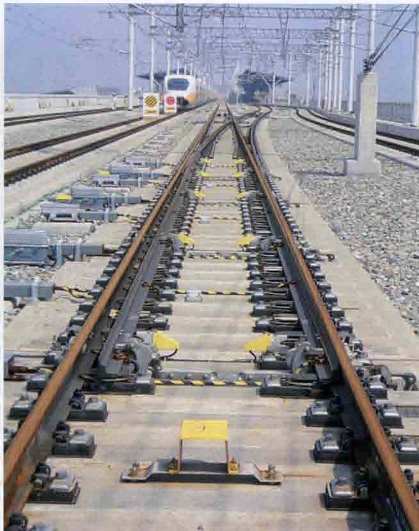
Рис. 6.51. Стрелочный перевод с крестовиной марки 1/32 на ВСМ. Тайвань
