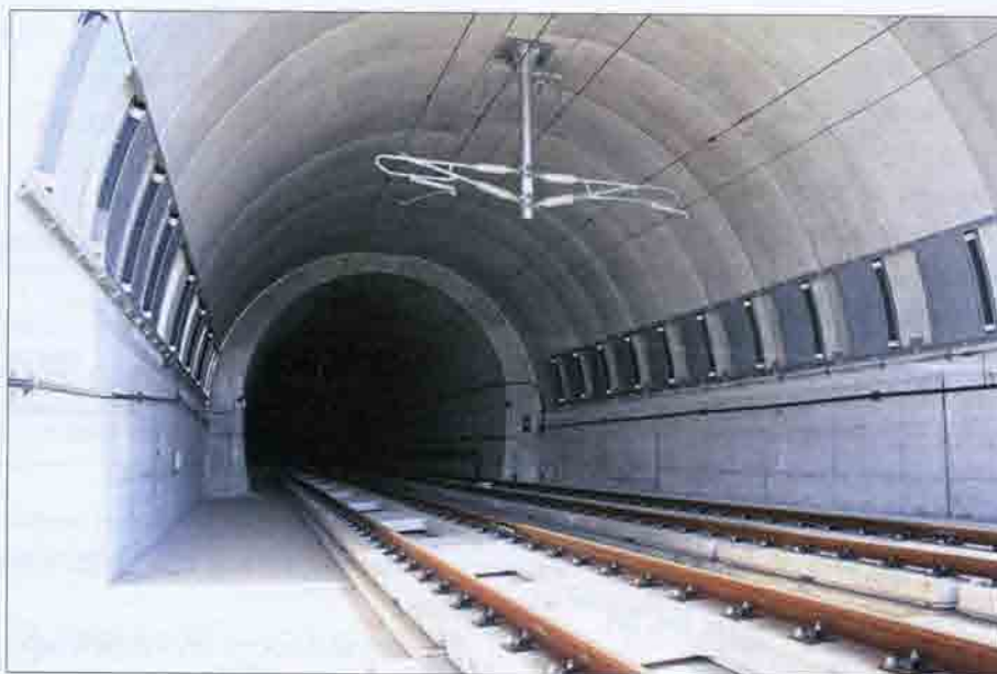
Рис. 10.53. Контактная сеть в двухпутном тоннеле на ВСМ «Кюсю». Япония. 2010 г.
