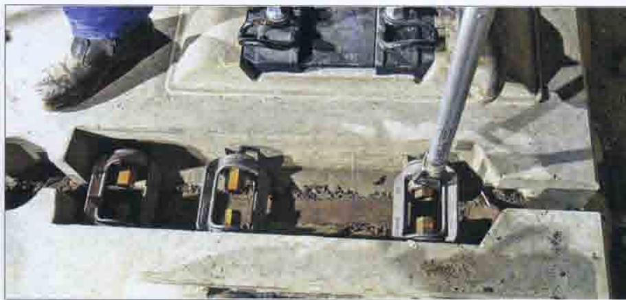
Рис. 6.40. Соединение плит типа «Bögl» между собой с натяжением продольных стержней арматуры
