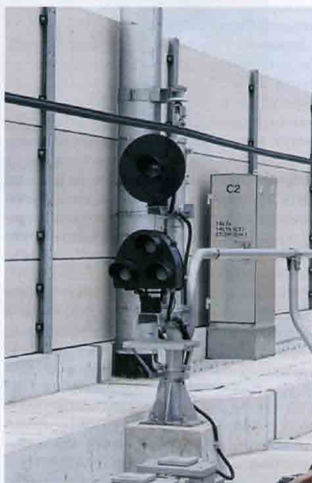
Рис. 11.4. Маневровый светофор на ВСМ «Кюсю». Япония. 2011 г.
