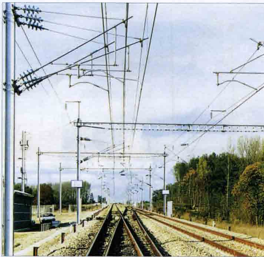
Рис. 10.31. Контактная подвеска на ВСМ с максимальной скоростью движения 300 км/ч в районе воздушной стрелки. Франция. 2000 г.
