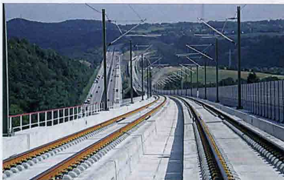
Рис. 6.32. Общий вид пути типа «RHEDA-2000» на эстакаде. Германия. 2010 г.
