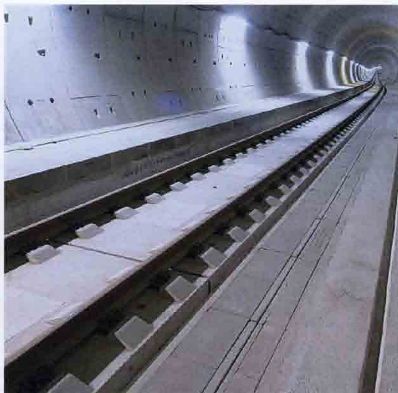
Рис. 6.47. Путь системы «ÖBB Pörr» в тоннеле на подходе к Главному вокзалу Берлина. 2008 г.
