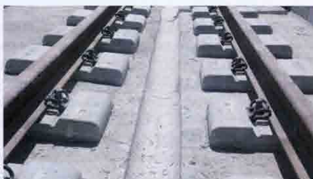
Рис. 6.47. Путь системы «ÖBB Pörr» в тоннеле на подходе к Главному вокзалу Берлина. 2008 г.
