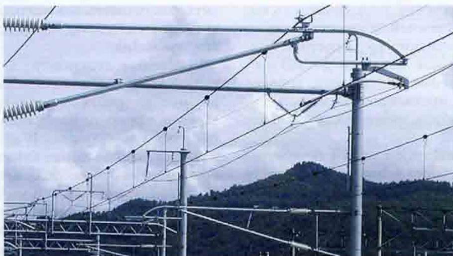
Рис. 10.17. Участок контактной подвески с биметаллическим контактным проводом на японской высокоскоростной железной дороге. Япония. 2005 г.
