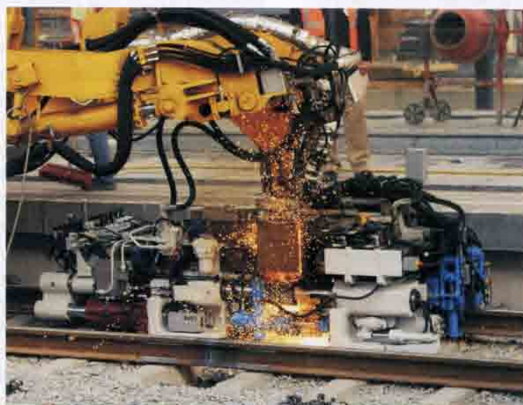
Рис. 6.5. Сварка рельсовых плетей: а — алюминотермитная сварка; б — контактная электросварка с использованием роботизированного комплекса АРТ 1500 компании Plasser & Theurer (общий вид); в — рабочий орган комплекса АРТ 1500 в процессе сварки
