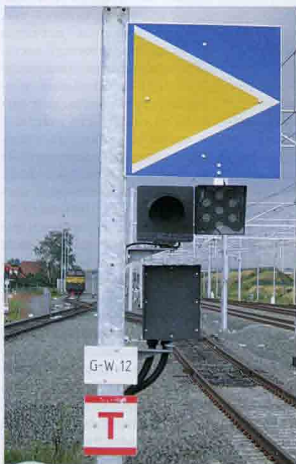
Рис. 11.3. Маневровый светофор со знаком границы блок участка. ВСМ. Бельгия. 2010 г.
