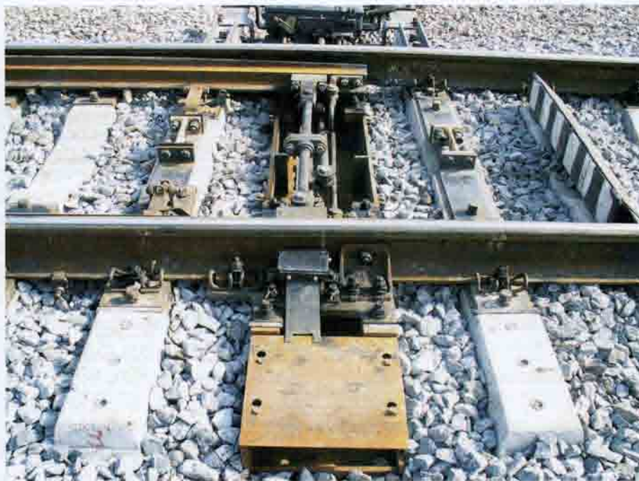
Рис. 6.60. Полые металлические брусья переводов, оборудованные крышками для защиты от грязи
