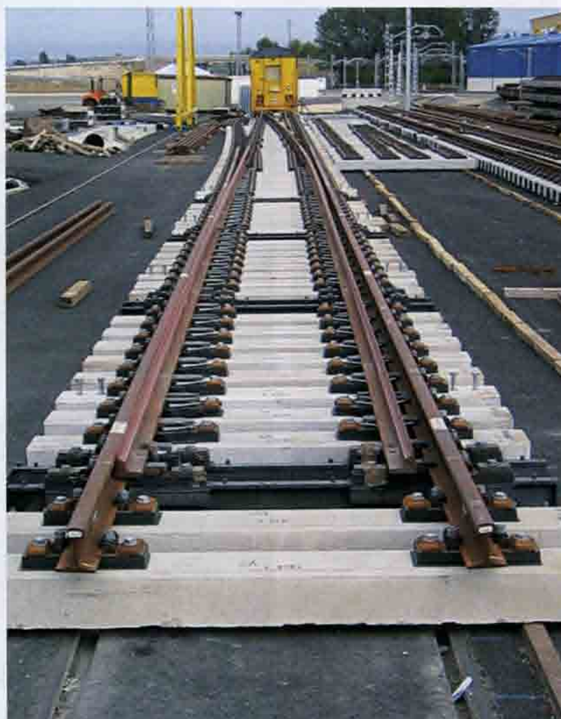
Рис. 6.54. Стендовая сборка стрелочного перевода. Испания. 2009 г.
