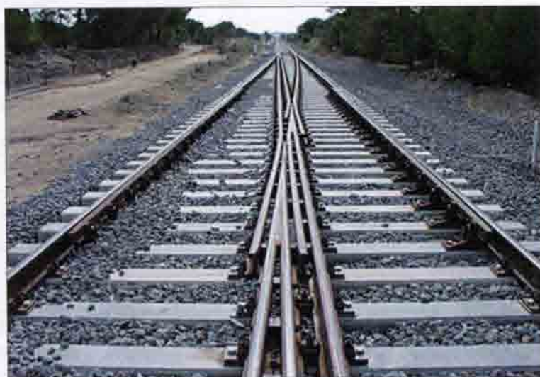
Рис. 7.3. Совмещенный участок ВСМ с нормальной колеей 1435 мм и линии с иберийской колеей (1668 мм): а — путь на перегоне; б — стрелочный перевод. Испания
