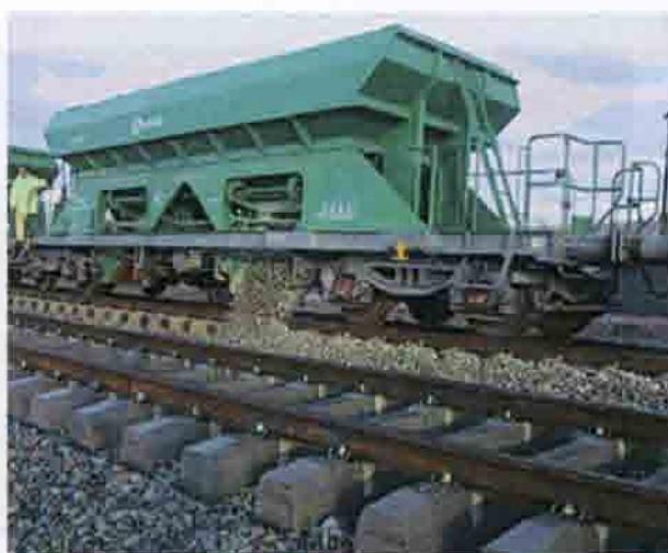
Рис. 6.21. Выгрузка балласта из хоппера-дозатора на путь
