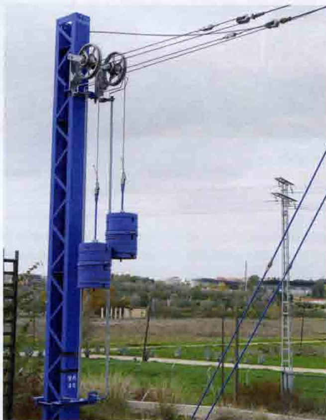
Рис. 10.32. Устройство контактной сети системы 2 \times 25 кВ, 50 Гц: а — итальянские ВСМ: 1 — анкеруемые контактный провод и несущий трос нечетного пути; 2 — то же четного пути; 3 — рабочие ветви контактной подвески нечетного и четного путей; 4 — изолированная консоль четного пути; 5 — изолированные консоли рабочей и анкеруемой ветвей контактной подвески, консоль для организации воздушной стрелки; 6 — устройство автоматического натяжения контактных проводов и несущих тросов (блочно-полиспастные грузовые компенсаторы); 7 — опорные конструкции рамного типа с жесткой поперечиной; 8 — питающий провод; 9 — обратный провод; 10 — трансформаторная подстанция нетяговых потребителей; 11 — надставки для крепления питающих проводов 2 \times 25 кВ; 12 — питающие (фидерные) линии 2 \times 25 кВ; б — испанские ВСМ — анкерная опора контактной подвески с грузовым компенсатором барабанного типа на тупиковом станционном приеме-отправочного пути. Испания. ВСМ Мадрид — Толедо. 2012 г.
