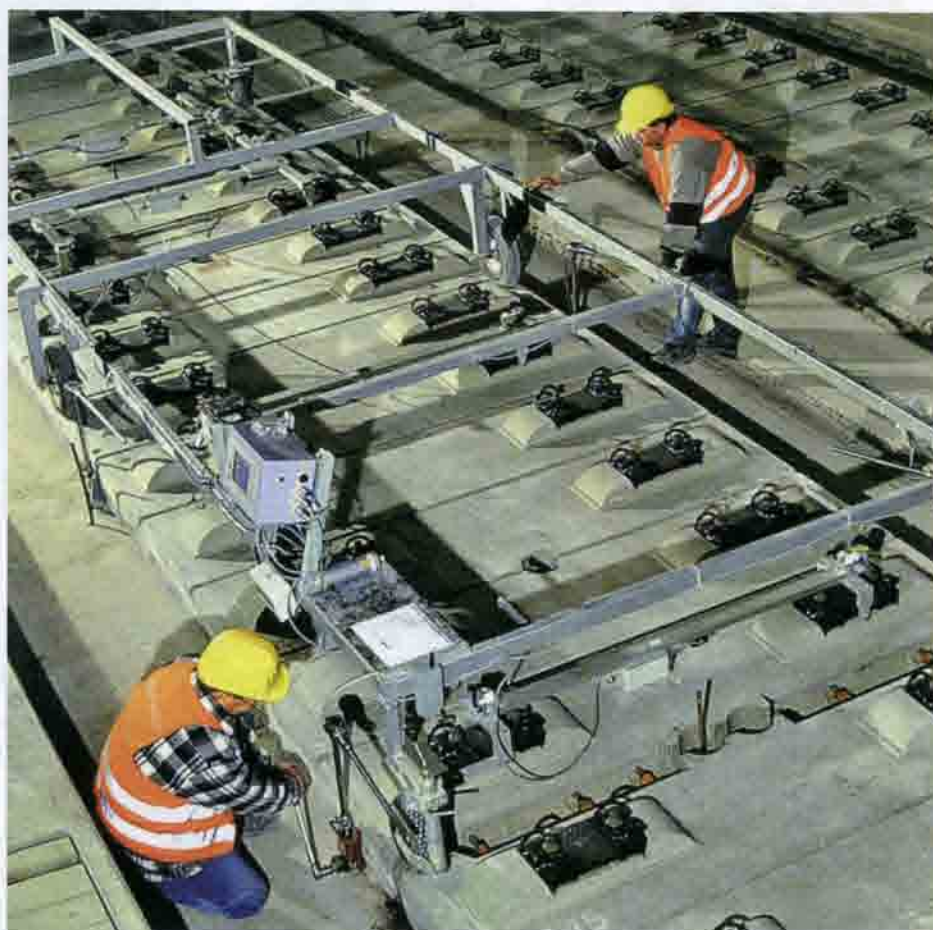
Рис. 6.39. Установка плит типа «Vögl» на подготовленное основание с помощью монтажной рамы
