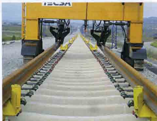
Рис. 6.19. Варианты применения различных машин при укладке (надвижке) рельсовых плетей на шпалы
