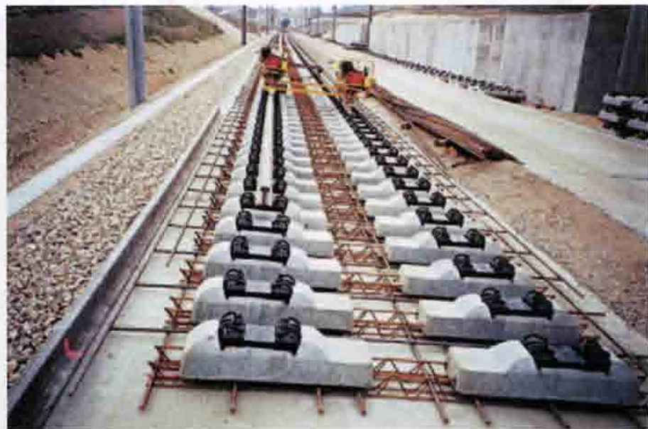
Рис. 6.34. Общий вид конструкции пути типа «RHEDA-2000», подготовленной к заливке бетоном. Германия. 2010 г.
