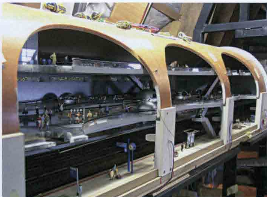
Рис. 8.28. Макет станции «Порта Альпина»: пассажирские платформы на первом этаже соединяют с распределительным залом и залом ожидания на втором и третьем этажах эскалаторы и лестницы; с третьего этажа скоростные лифты доставляют пассажиров на поверхность
