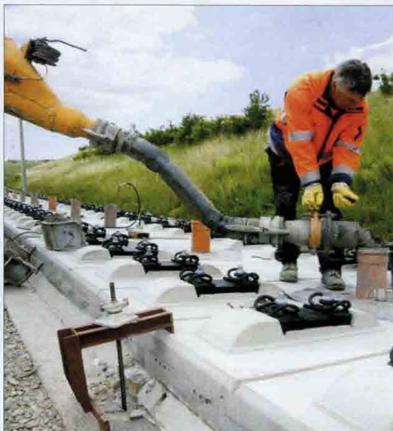
Рис. 6.41. Заполнение цементным раствором полости между плитой и бетонным основанием
