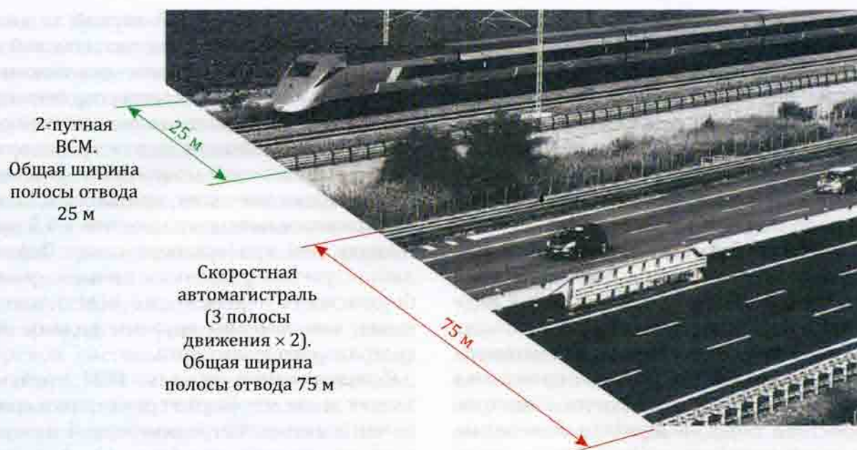
Рис. 3.2. Сопоставление полосы отвода, необходимой для строительства ВСМ и скоростной автомагистрали, одинаковой провозной способности
