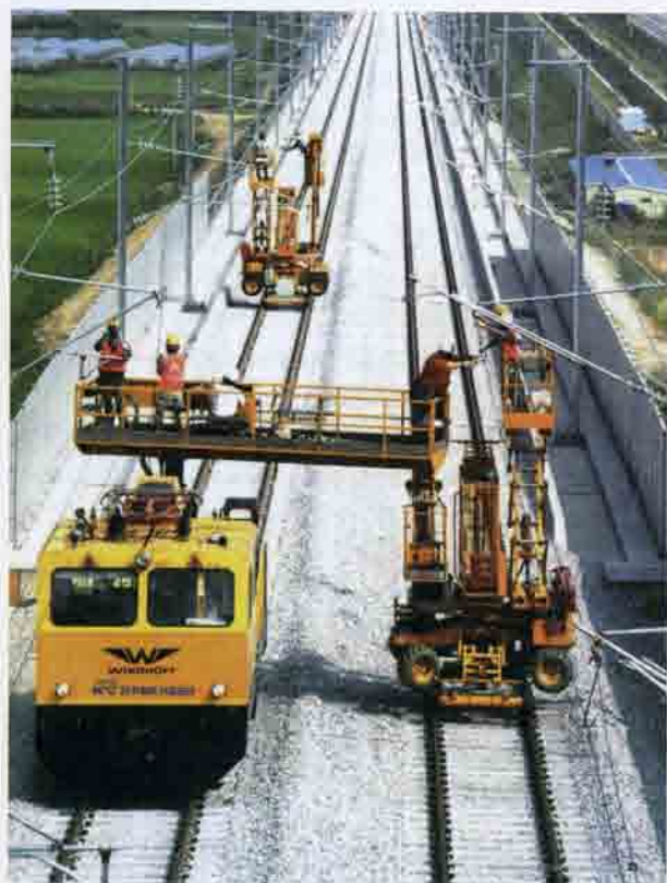
Рис. 10.50. Монтаж контактного провода на ВСМ с передвижных вышек на смешанном автомобильно-железнодорожном ходу. 1990-е годы
