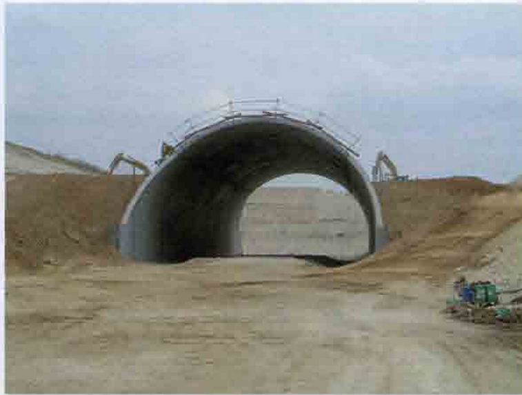
Рис. 8.18. Строительство малого искусственного сооружения — автомобильно-пешеходного тоннеля, одновременно с отсыпкой земляного полотна. Испания. 2007 г.
