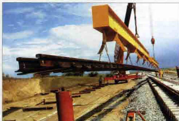
Рис. 6.55. Доставка длинномерных элементов стрелочного перевода автотранспортом. Тайвань. 2004 г.
