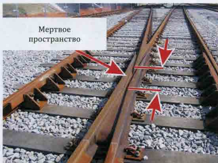
Рис. 6.50. Крестовины стрелочных переводов: а — литая (стрелками показано «мертвое пространство»: здесь колесо, переходя с одной рельсовой нити на другую, на некотором отрезке пути теряет опору); б — крестовина с подвижным сердечником, обеспечивающая непрерывную поверхность катания колеса
