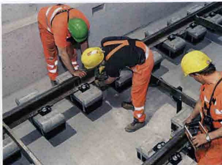
Рис. 6.49. Монтаж конструкций пути типа LVT
