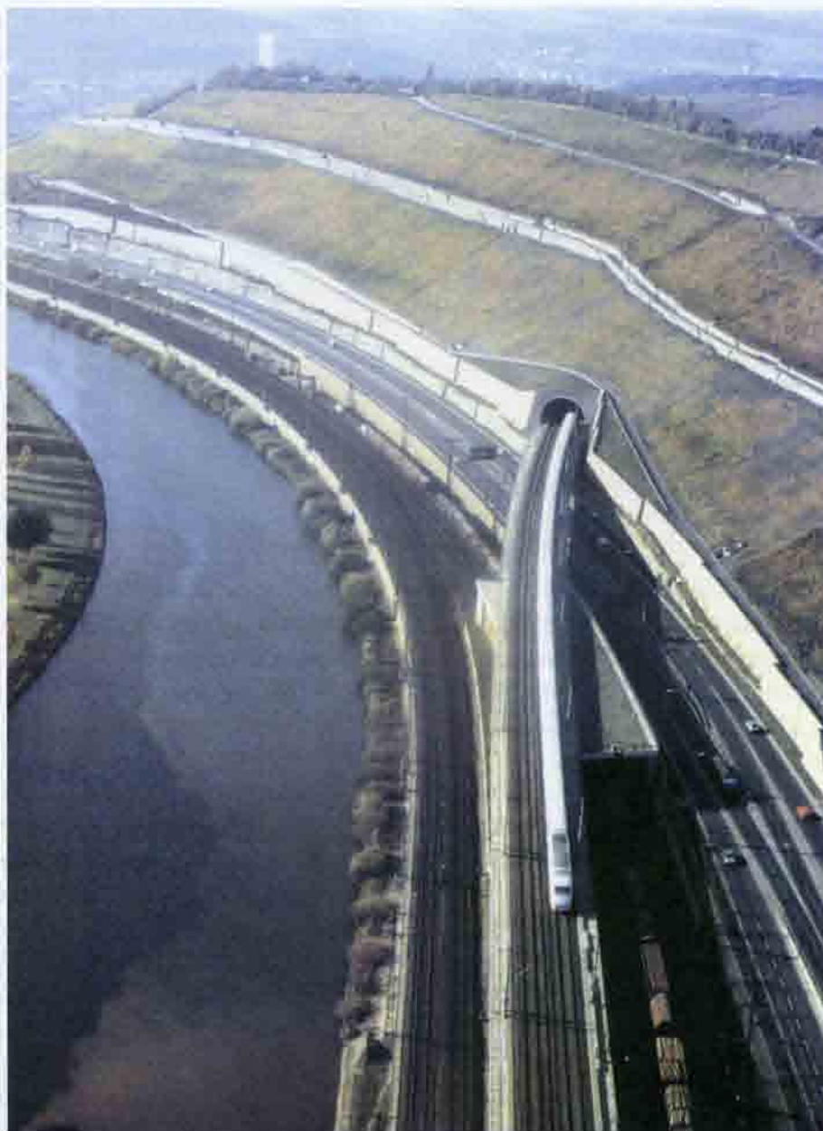
Рис. 8.19. Тоннель на ВСМ, Германия. На фото видно, что трассы построенных ранее железной дороги и автомобильного шоссе следуют вдоль речной долины, повторяя очертания ее берегов. ВСМ проложена в тоннеле по кратчайшему направлению
