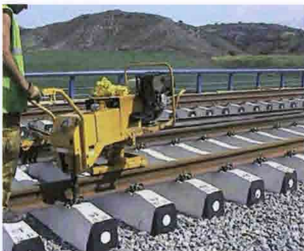
Рис. 6.20. Механизированное закрепление рельсов на шпалах
