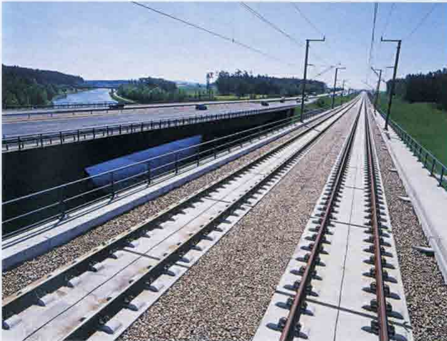
Рис. 6.36. Верхнее строение пути типа «Bögl» с междупутьем, засыпанным балластом, на высокоскоростной железнодорожной магистрали Нюрнберг — Игольштадт. Германия. 2009 г.
