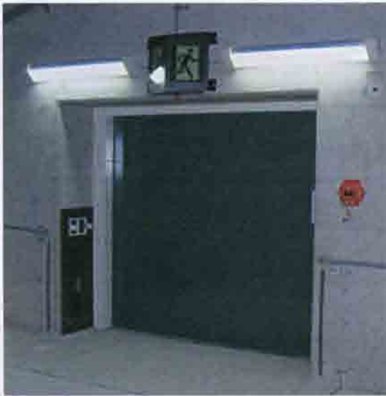
Рис. 8.41. Герметичные двери эвакуационного выхода в тоннеле ВСМ. 2008 г.
