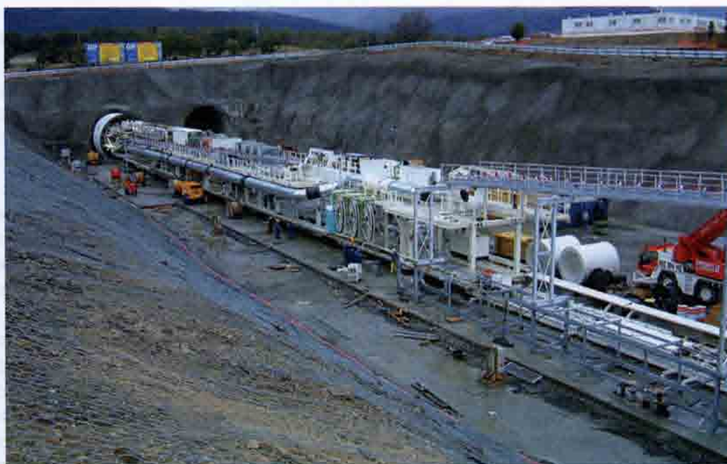
Рис. 8.45. Механизированный проходческий комплекс на строительстве тоннеля Гвадаррама. Испания
