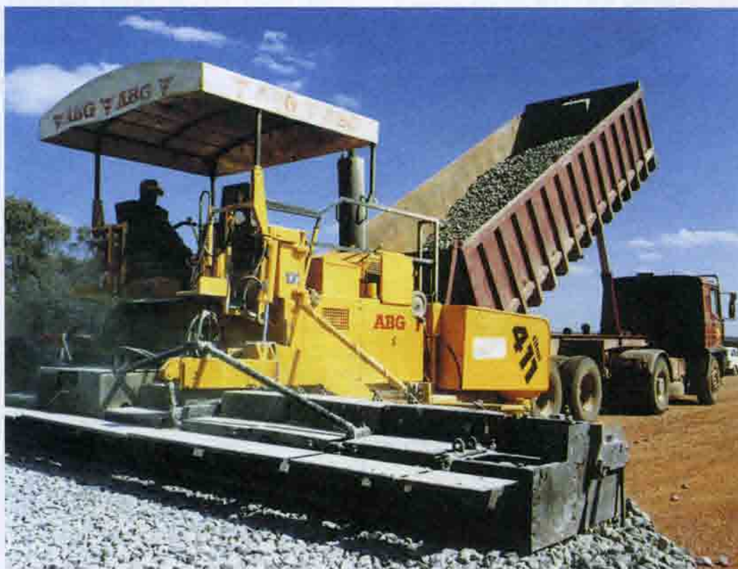
Рис. 6.11. Механизированная укладка балластного слоя на строительстве ВСМ Мадрид — Севилья. Испания. 1990 г.
