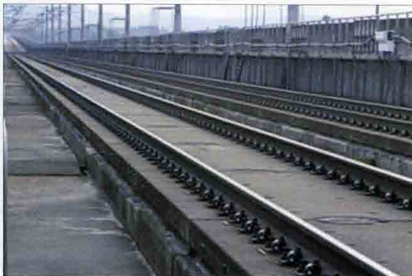
Рис. 6.26. Безбалластный путь японских ВСМ на плитном основании
