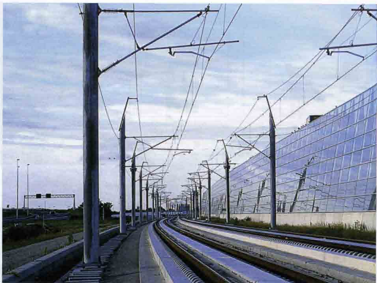
Рис. 3.19. Звукоизолирующий барьер на ВСМ «Юг». Нидерланды. 2008 г.
