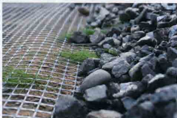
Рис. 6.2. Сооружение земляного полотна: а — общий вид строительных площадок на ВСМ Рона — Альпы (Франция, 90-е годы XX в.); б — укладка геотекстиля; в — укладка геосетки
