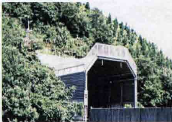
Рис. 8.35. Решетчатая конструкция обрамления портала тоннеля на ВСМ «Санъё», Япония
