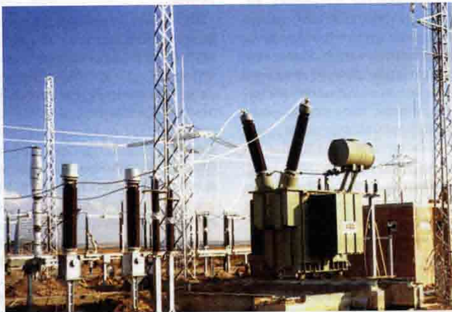
Рис. 10.18. Схема питания подстанций с однофазными трансформаторами от высоковольтной линии ВЛ220 кВ по 60-градусной схеме симметрирования нагрузок: а — фрагмент схемы питания высокоскоростной линии Мадрид — Севилья (Испания); б — общий вид однофазного трансформатора на одной из тяговых подстанций ВСМ Мадрид — Севилья. Испания. 1991 г.
