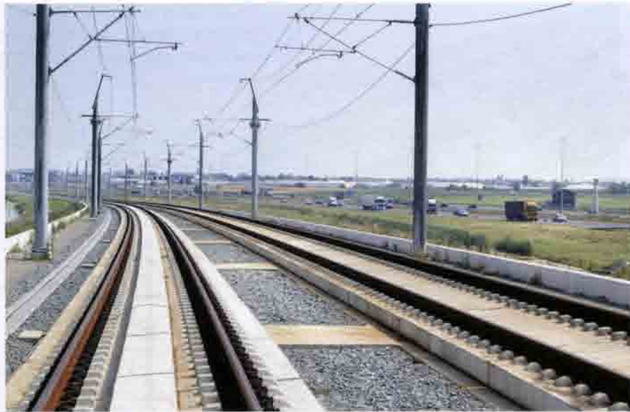
Рис. 6.33. Общий вид пути типа «RHEDA-2000» на земляном полотне. Нидерланды. 2010 г.
