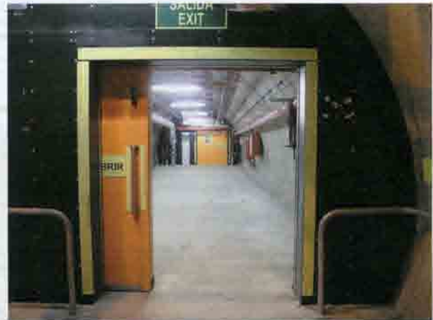
Рис. 8.41. Герметичные двери эвакуационного выхода в тоннеле ВСМ. 2008 г.
