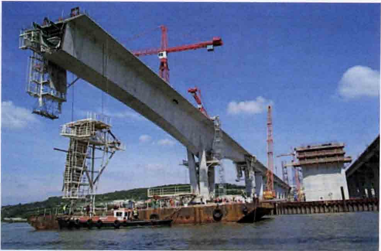
Рис. 8.10. Сооружение моста с железобетонными пролетными строениями на ВСМ Лондон — Тоннель под Ла-Маншем. Англия
