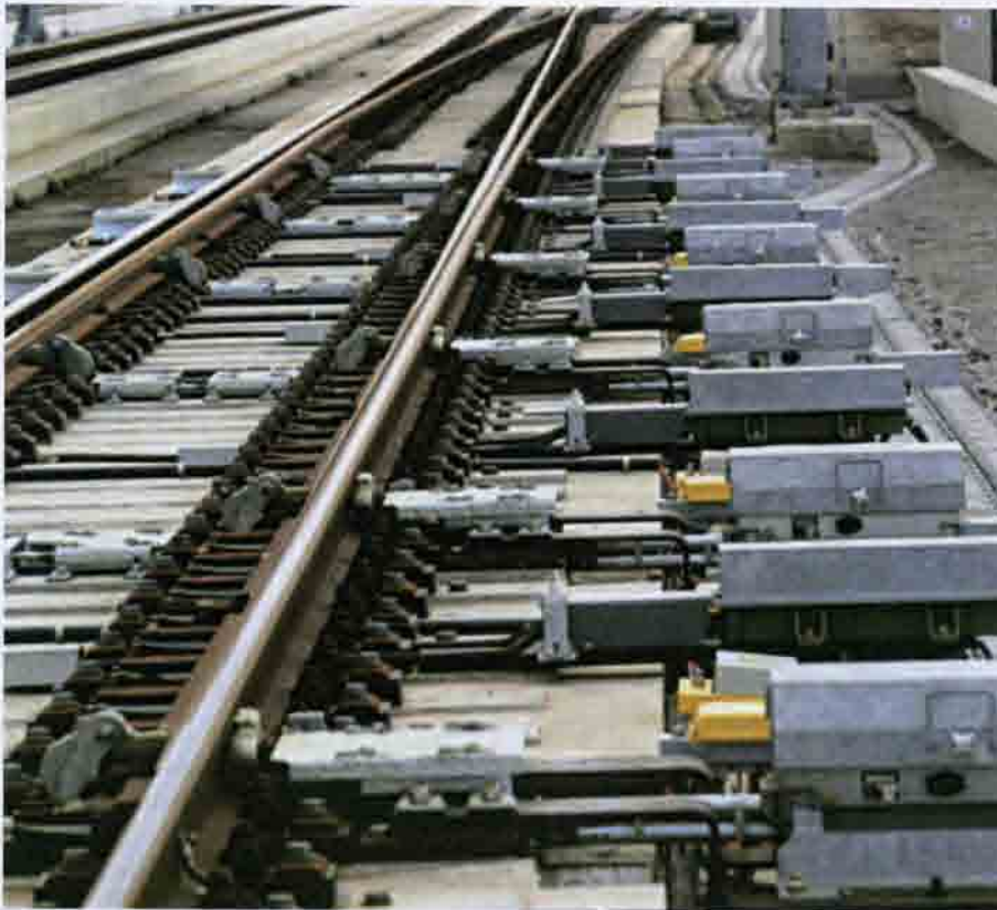
Рис. 11.10. Приводы остряков стрелочного перевода на ВСМ. Нидерланды. 2010 г.
