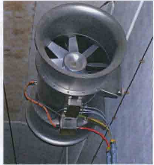
Рис. 8.40. Струйный вентилятор в тоннеле ВСМ «Юг», Нидерланды. Как правило, подобные вентиляторы устанавливаются в автомобильных тоннелях. 2008 г.
