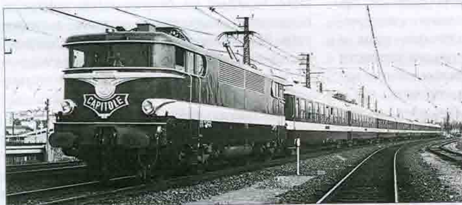
Рис. 1.14. Поезд «Капитоль». Первый в Европе экспресс с максимальной скоростью движения 200 км/ч. Франция. 1967 г.
