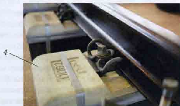
Рис. 6.48. Путь типа LVT со креплениями Vossloh (а); основные элементы (б, в): 1 — бетонный блок; 2 — эластичная прокладка и 3 — резиновый чехол, заключенные в монолит бетонной плиты; 4 — бетонные моноблоки
