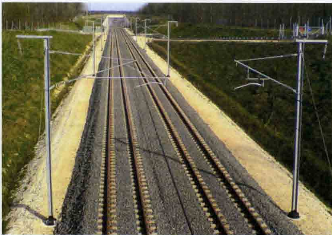
Рис. 6.16. Путь с двухблочными шпалами. ВСМ «Восток». Франция
