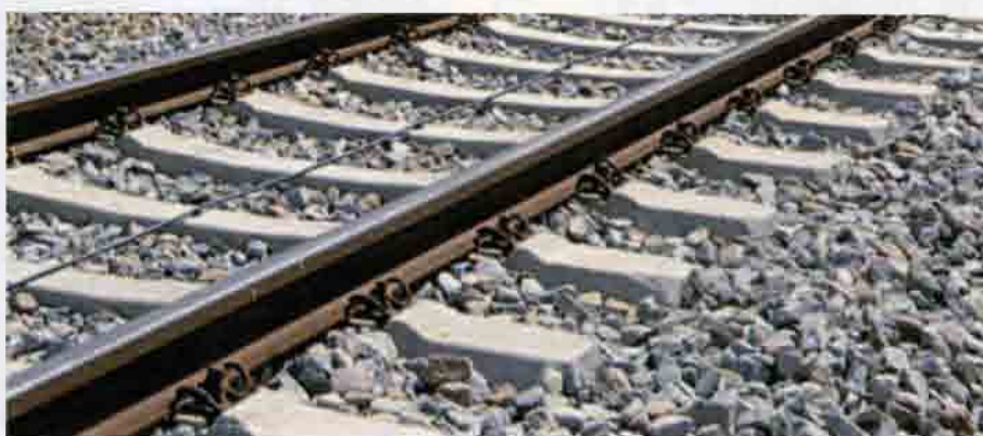
Рис. 6.14. Путь со шпалами типа В70. Германия
