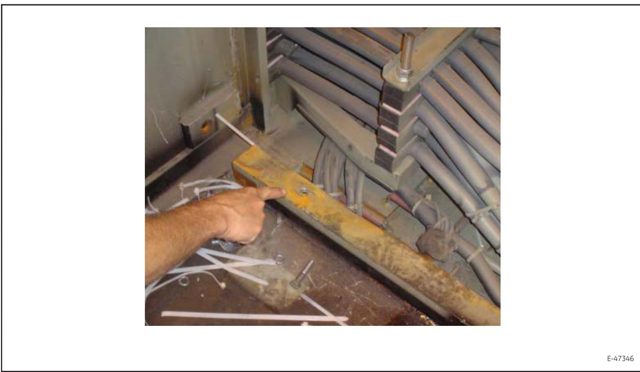
Рис. 84. Отсек генератора, снятие скрытого болта
