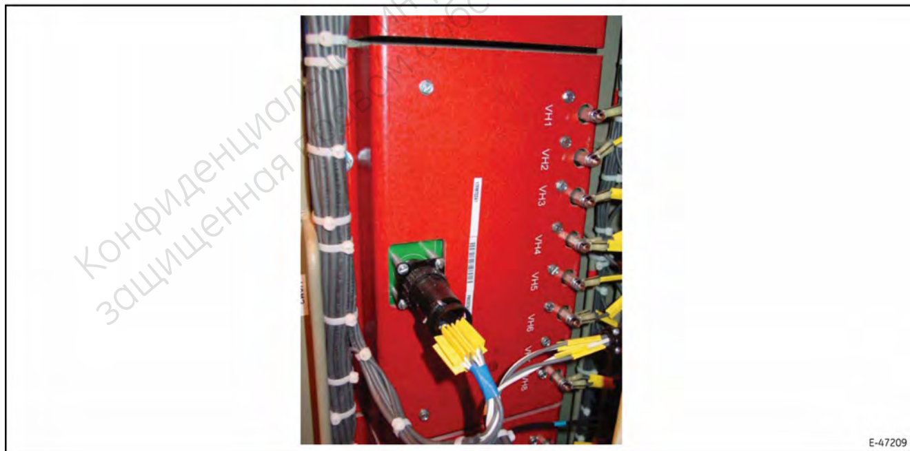
Рис. 18. Модуль уменьшения напряжения (VAM).
