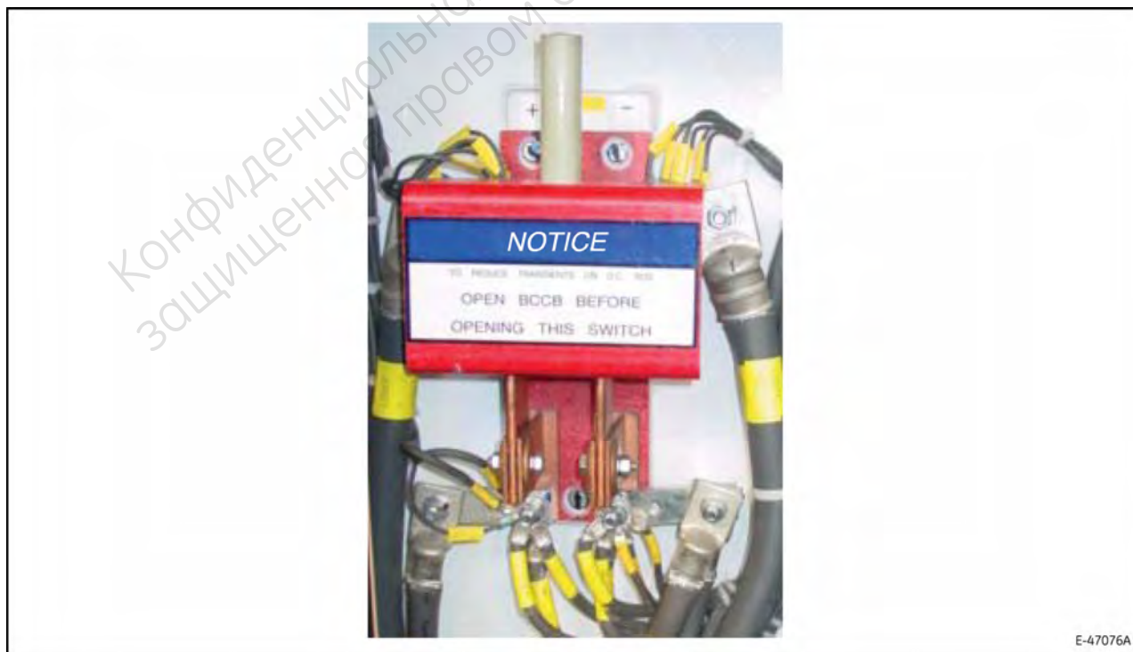
Рис. 24. Переключатель аккумулятора (BS).
