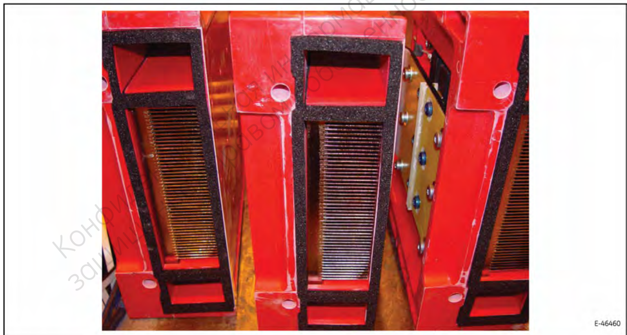
Рис. 30. Уплотнение воздушного канала на задней стороне IGBT-модуля фазы.
