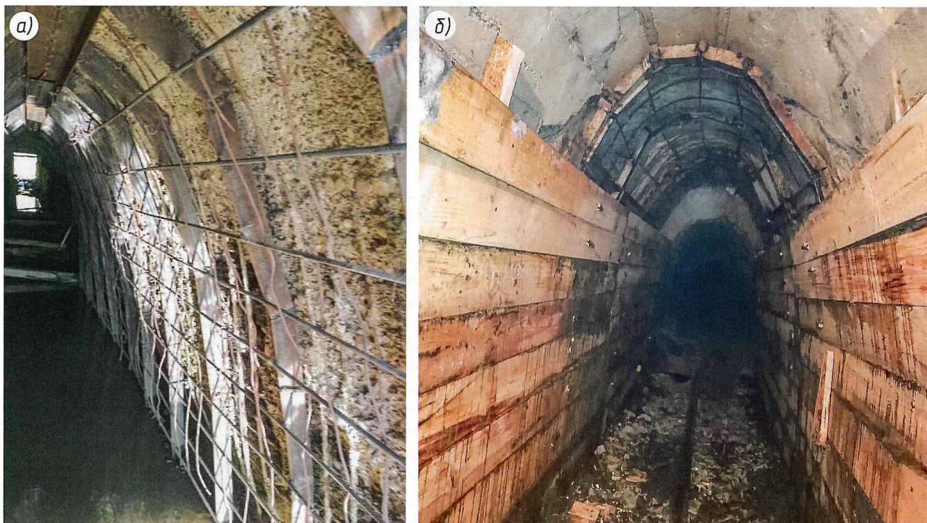
Рис. 4. Устройство металлического каркаса (а) и опалубки (б)
