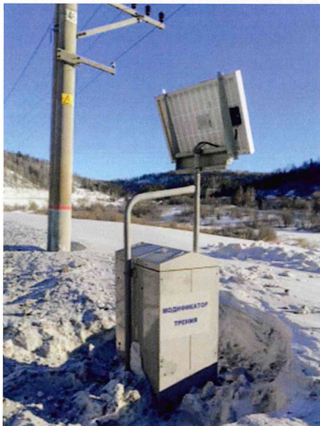
Рис. 2. Прибор для нанесения модификатора трения на оба рельса LubriCurve Electro 10
