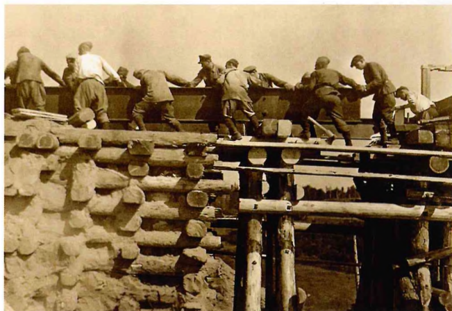
Рис. 4. Разборка и переустройство моста на Калининской железной дороге. Западный фронт, апрель 1943 г. Головной ремонтно-восстановительный поезд № 51 (из альбома выпускника 1940 г. Н.Б. Казина)
