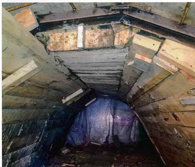
Рис. 3. Устройство тепловых экранов
