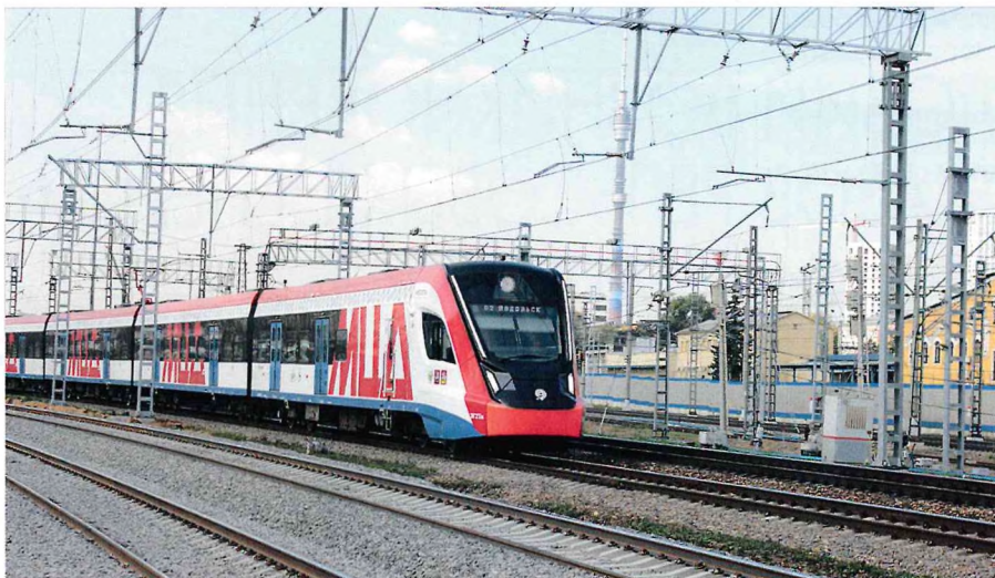
Станция Рижская, оснащенная МПЦ-ЭЛ
