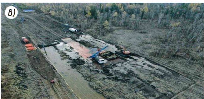
Рис. 2. Различные варианты применения «МДП МОБИСТЕК-80»: организация проезда тяжелой гусеничной техники на переувлажненных грунтах (а), организация проезда тяжелой колесной техники (б), производство работ на обводненных грунтах (в)
