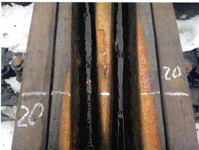
Рис. 3. Выкрашивание поверхности катания крестовины стрелочного перевода типа Р65 марки 1/11
