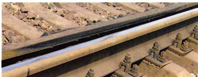
Рис. 1. Износ, спливы и отслоение металла на контррельсе уголкового профиля
