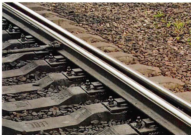
Рис. 4. Боковой износ головки криволинейного острия стрелочного перевода типа Р65 марки 1/11 проекта 2768
