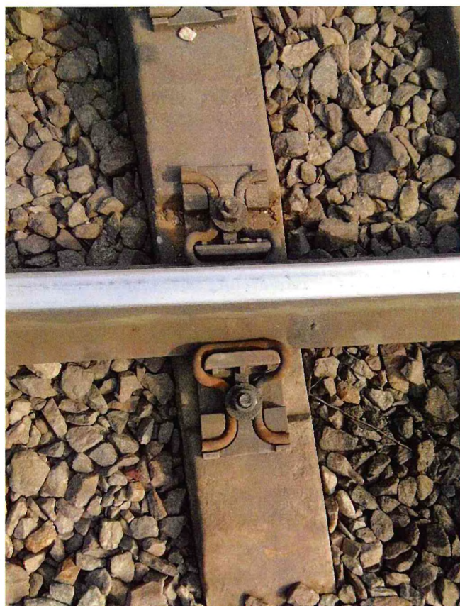
Рис. 7. Подкладка из композитных материалов на соединительных путях симметричного стрелочного перевода типа Р65 марки 1/6 проекта 2628
