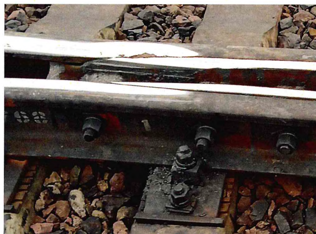
Рис. 5. Боковой износ литой части усювика с выкрашиванием в зоне сочленения с рельсовой частью
