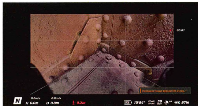
Рис. 2. Трещина, обнаруженная при осмотре моста с помощью FPV-дрона
