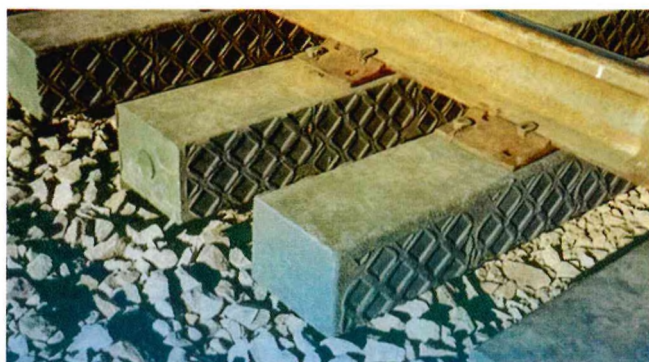
Рис. 2. Композитные шпалы с текстурированной поверхностью [10]
