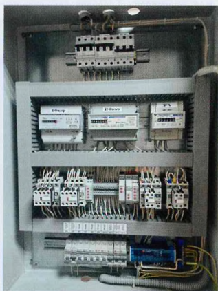
Запроектированные щиты энергоснабжения ШАВР до и после модернизации
