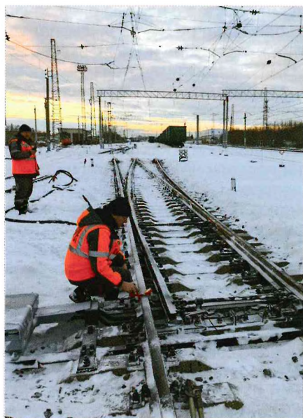
Электромеханики А.В. Климов и К.М. Морозов выполняют работу по измерению переводных усилий электропривода
