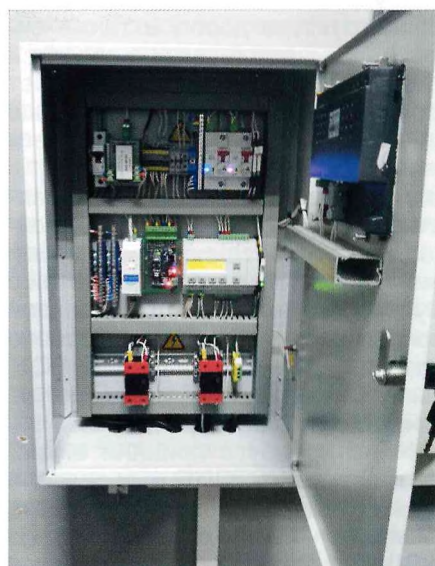
Новые ШАВР для размещения системы контроля и управления в связевых помещениях, где не установлены модульные контейнеры
