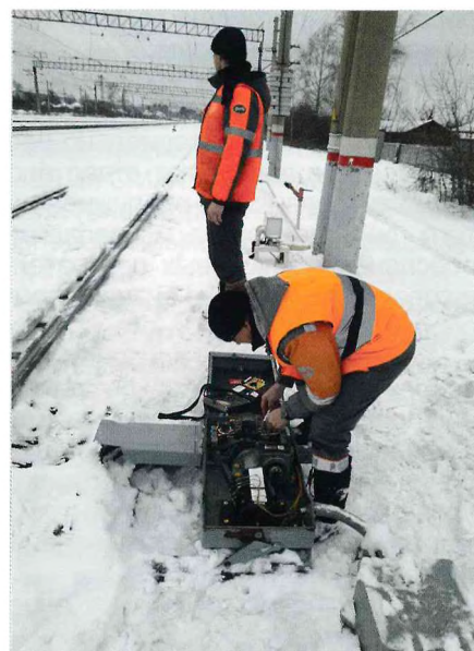
Электромеханики А.Е. Коркенлендер и А.Н. Васильев проверяют внутреннее состояние электропривода
