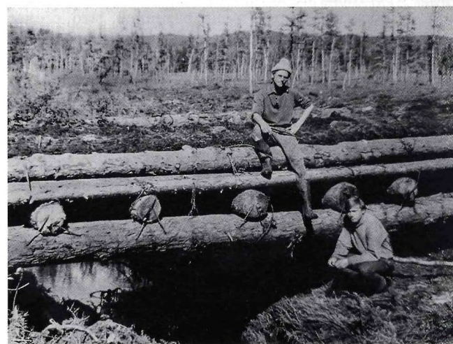
Рис. 7. Притрассовая дорога участка Тында—Чара. Технологический мост, построенный ССО МИИТа в июле 1975 г., который в августе снес мощный поток разлившейся реки (Фото из личного архива Ю.М. Боровкова)
