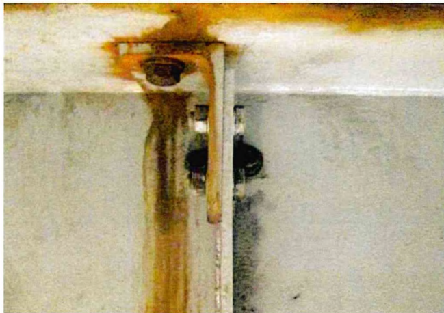
Рис. 2. Узел сопряжения ребра с поясом балки
