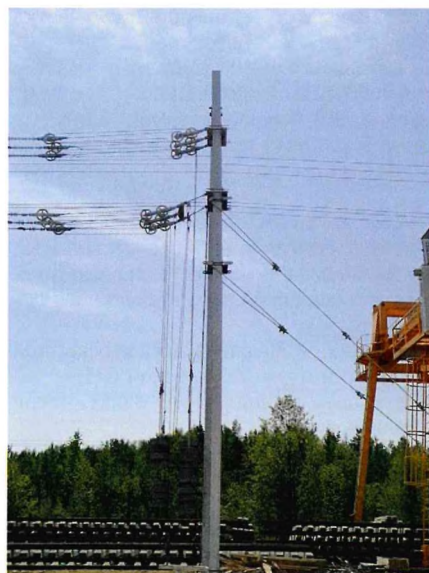
Рис. 1. Питание крана открытым троллеем
