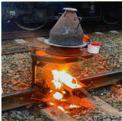
Рис. 2. Аллюминотермитная сварка рельсов
