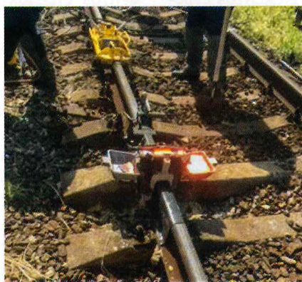
Рис. 5. Аллюминотермитная наплавка выемки в головке рельса, образовавшейся при вырезке дефекта
