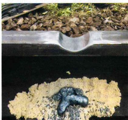
Рис. 4. С помощью газового резака из головки рельса удален дефектный фрагмент
