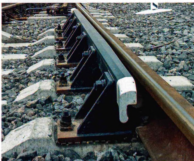
Рис. 1. Контррельсовый узел — ходовой рельс с контррельсом уголкового профиля СП-850
