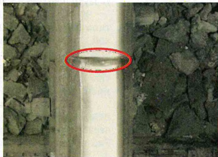
Рис. 1. Стыковые ступеньки, обнаруженные системой видеофиксации МСД
