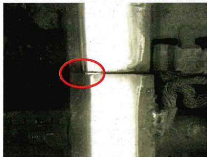
Рис. 1. Стыковые ступеньки, обнаруженные системой видеофиксации МСД
