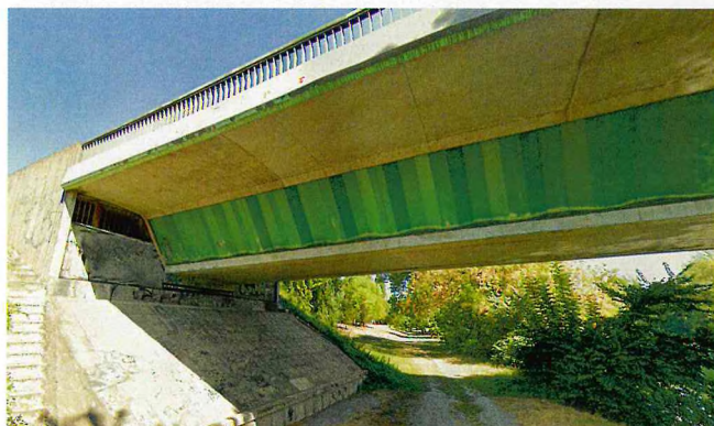
Рис. 1. Первый сталежелезобетонный мост с гофрированными стенками Pont de Cognac (Франция)
