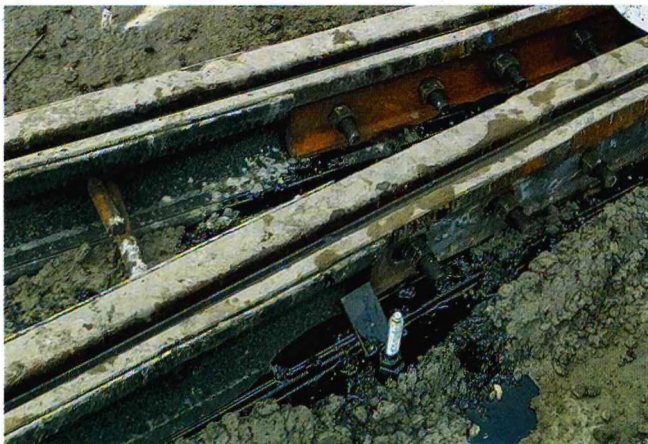
Рис. 2. Полиуретановая мастика в зоне специальных частей поверхности катания рельсов и колес подвижного состава, способы соединения рельсов, скорость движения и техническое состояние трамвая.
