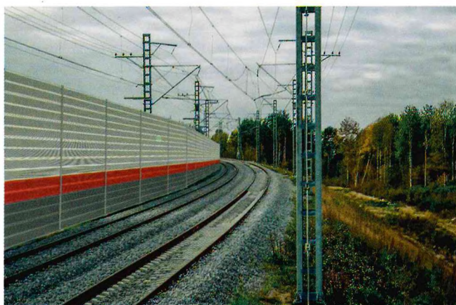
Рис. 1. Акустический экран вдоль железнодорожных путей
