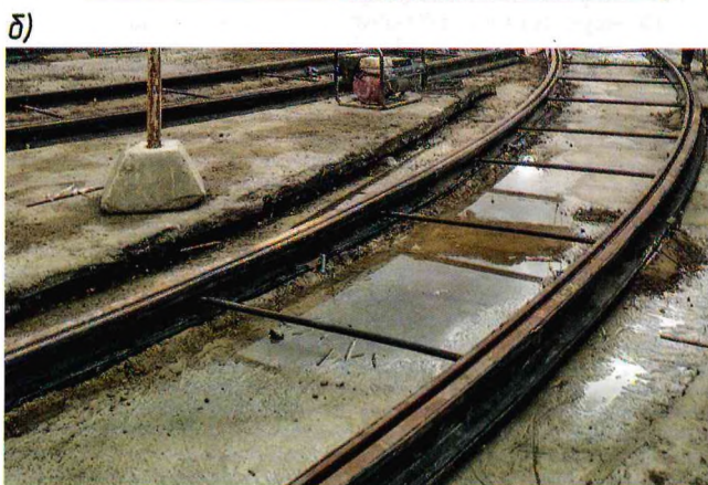
Рис. 1. Прирельсовые профили: а — общий вид; б — в трамвайном пути
