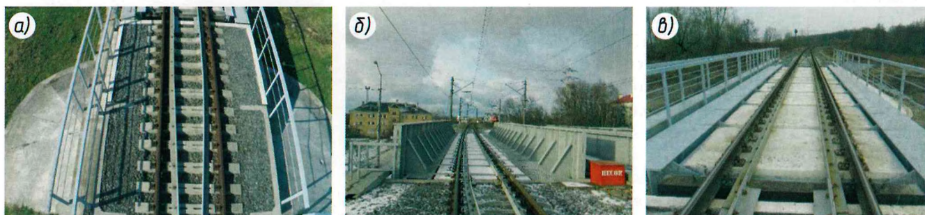
Рис. 3. Применение на Калининградской дороге изделий из композитных материалов: а — шпалы на железобетонном мосту; б — плиты на путепроводе; в — плиты на металлическом мосту
