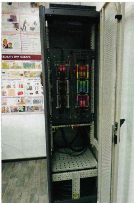
Стенд для измерений и поиска повреждений магистрального кабеля
