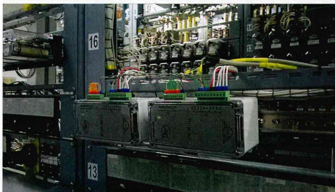
Блоки БПМ-МПЦ, размещенные на стative
