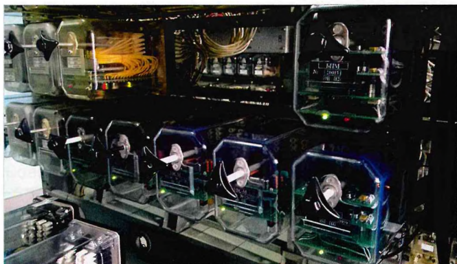
Постовые блоки САУТ-ЦМ/НСП при увязке с релейной ЭЦ
