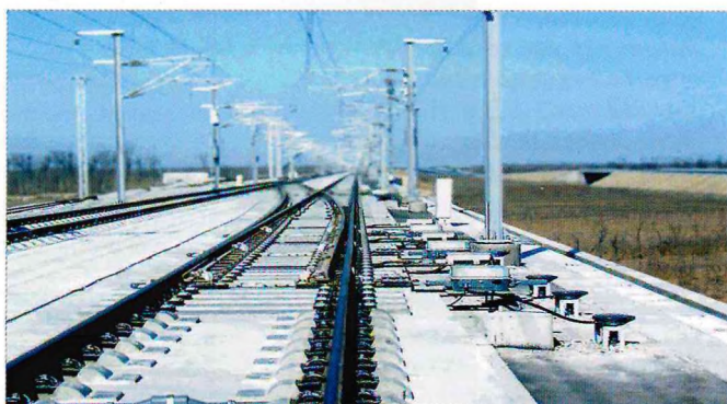
Стрелочный перевод 1/18 на безбалластном верхнем строении пути
