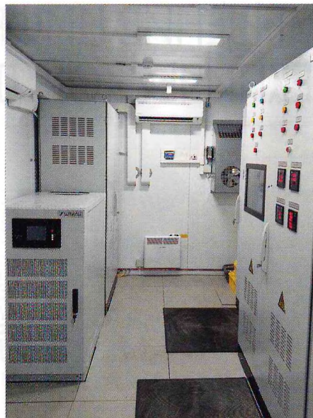
Унифицированное устройство электропитания УЭП-У-М со встроенной системой диагностики
