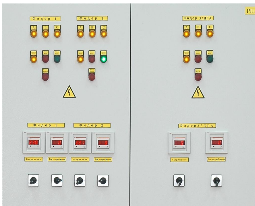
Рисунок 10.9 - Индикация исправной работы СПУ на двери шкафа РЩ При исправной работе УБП ЖКИ УБП имеет следующее отображение (рисунок 10.10):
