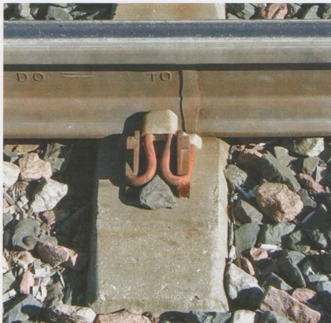
Рис. 1. Сварной стык после индукционной сварки без шлифовки шейки и верха подошвы после снятия грата
