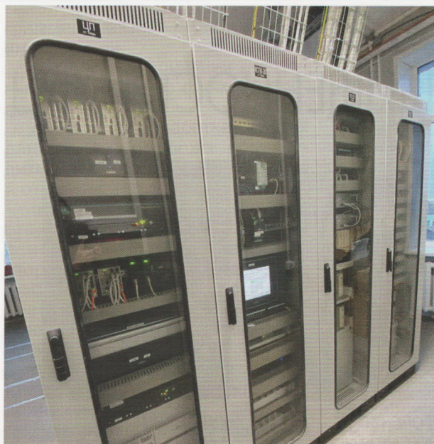
Пример размещения оборудования КСПК-ЭЛ на действующей станции: шкаф установлен в помещении релейной
