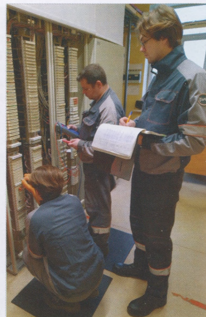
Электромеханики Московско-Рязанского РЦС М.Д. Витковский, С.А. Лаврик, И.О. Мурзаев во время проверки линейно-кабельного оборудования
