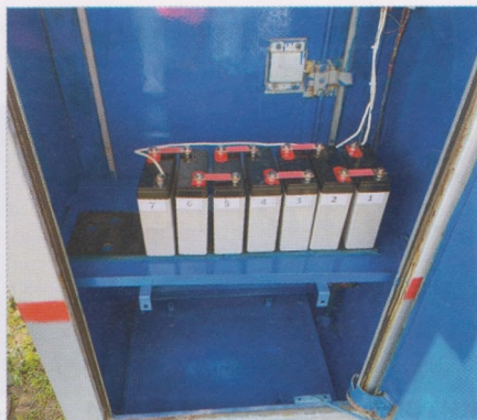
Аккумуляторы ШТАРК АГНГ на переезде Стенькино-2
