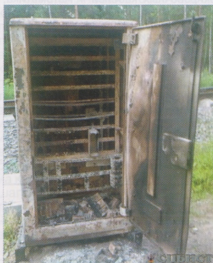
Поджог оборудования в релейном шкафу
