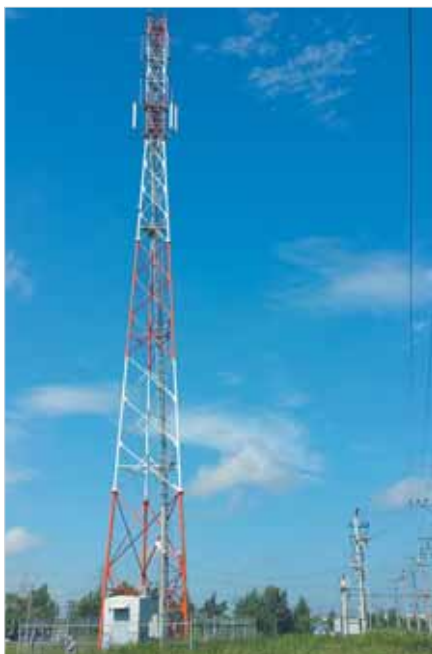
Антенно-мачтовое сооружение ЦСТР стандарта GSM-R
