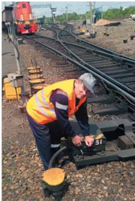
Электромеханик А.А. Суханов проверяет стрелочный электропривод
