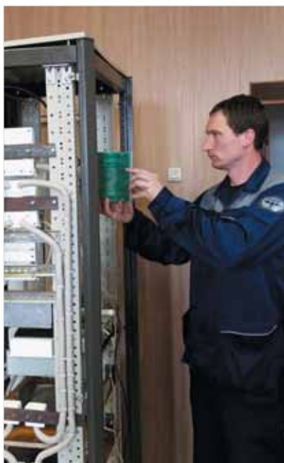
Электромеханик А.В. Абоймов осуществляет перенос оборудования радиосвязи в новый шкаф
