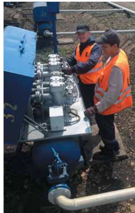
Электромеханики Е.С. Мерзлов и Е.А. Ильин проверяют питающую установку замедлителя
