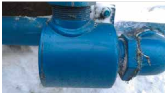
Клапан быстрого выхлопа
