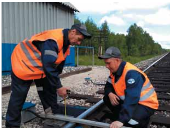
Электромеханики В.Б. Патрушев и И.В. Монжосин проверяют правильность установки napольной камеры
