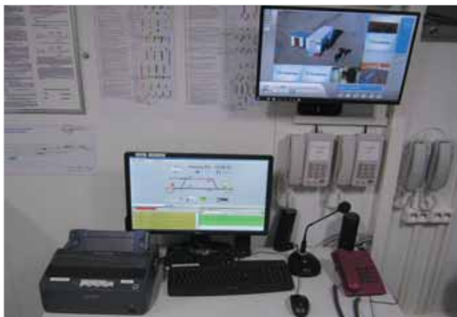
С помощью АРМ видеонаблюдения (вверху) отслеживается состояние всей инфраструктуры станции
