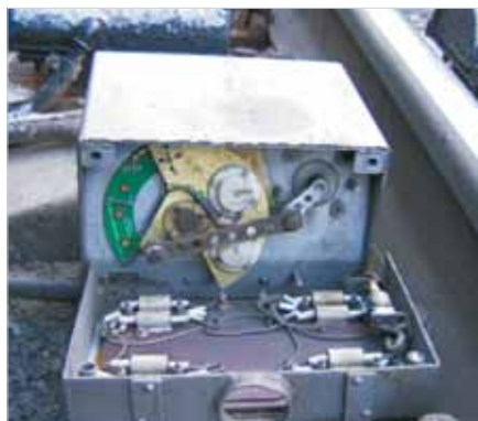
Напольная камера КНМ-05 на месте эксплуатации
