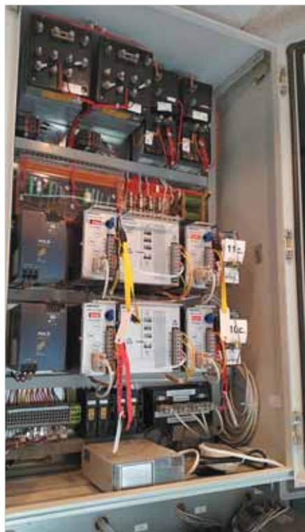
Аппаратура EBITrack 400, установленная на станции Рига-Пассажирская
