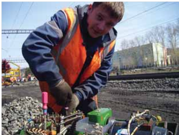
Начальник участка Е.С. Тишин регулирует контакты автопереключателя после замены электропривода
